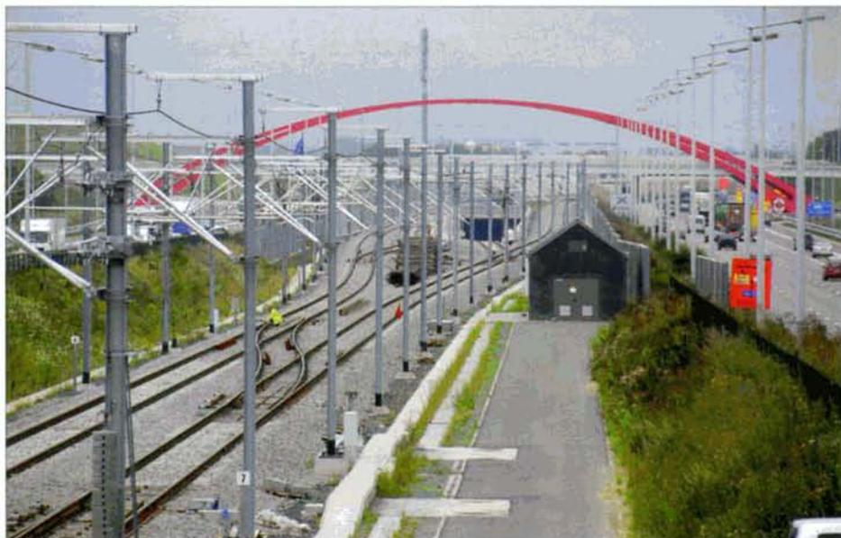
← Le chantier du Diabolo avance très vite; la pose des voies et caténaires est pratiquement achevée. Cette photo, prise au milieu de l'autoroute E19 (Bruxelles - Antwerpen), montre la bifurcation au nord du Diabolo. Les deux voies centrales plongeant vers le tunnel se dirigent vers l'aéroport. Les deux voies passant de part et d'autre du tunnel sont celles de la ligne 25N qui se dirige vers Schaerbeek et Bruxelles.
