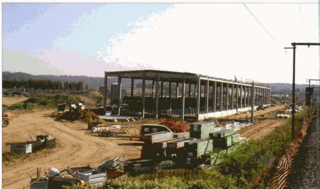
La construction du gros œuvre du futur poste d'entretien et de dépannage (PED) pour automotrices Desiro d'Ottignies se poursuit. Le hall de 110 mètres de longueur comprendra deux voies (voir à ce sujet le *EN LIGNES 103* page 21).
