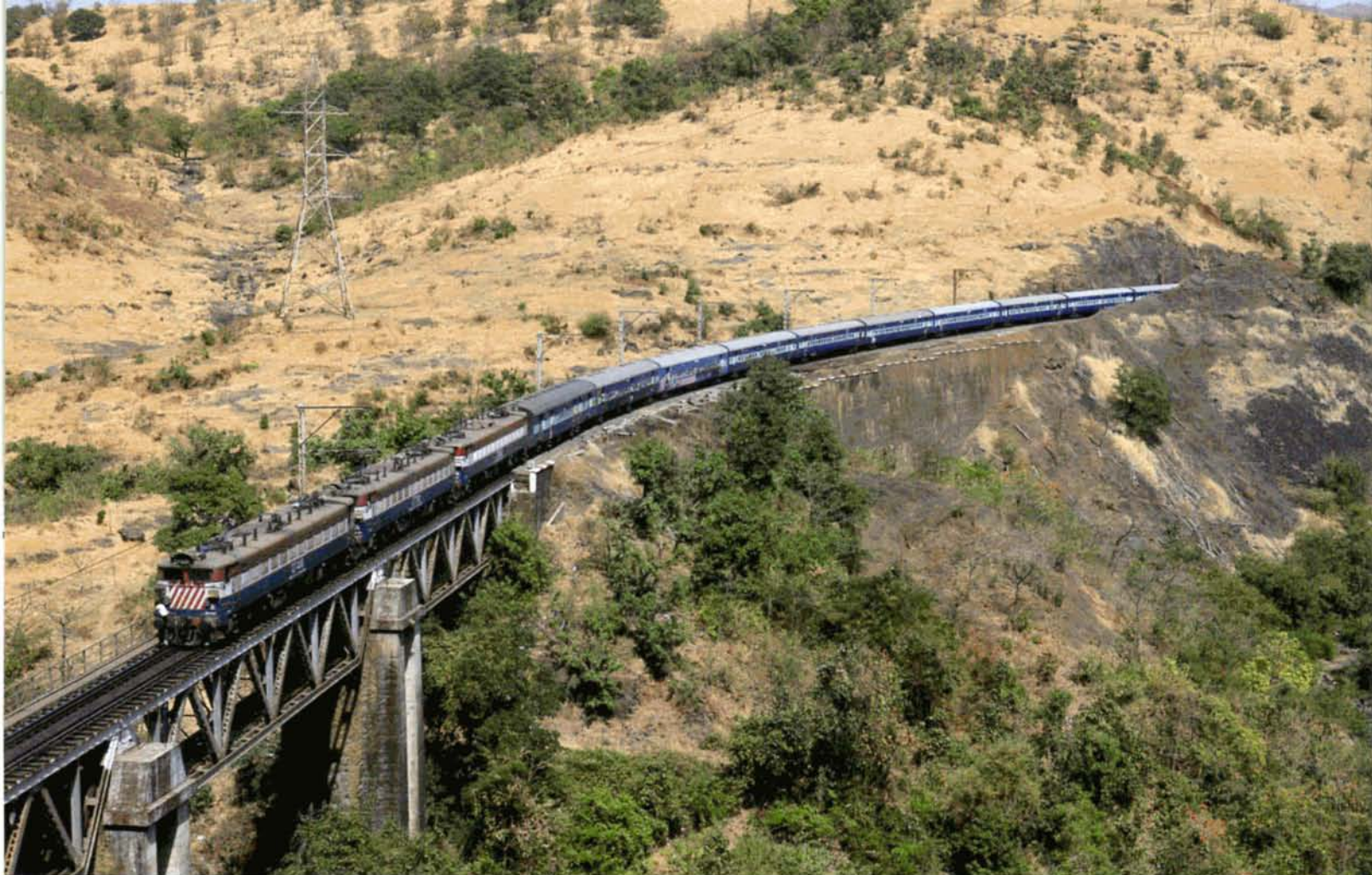
PHOTO 110-92 Le 21 février 2012, un train de voyageurs franchit le viaduc de Bhima I, près d'Igatpuri, sur la ligne Mumbai - Calcutta. Etablie en rampe de plus de 25‰ pour franchir les Ghâts, elle nécessite d'alléger tous les trains par des couplages de 3 locomotives accrochées en queue. Ce train de 25 voitures, dont seules les 10 dernières sont visibles sur la photo, est poussé par trois locomotives du type WAG7, les 27125 + 27121 + 27228. On remarquera un voyageur resquilleur accroché à l'arrière de la machine de queue. Les WAG7 sont des Co'Co' de 133 t produites à partir de 1992 à plus de 200 unités par Chittaranjan Locomotive Works. D'une puissance de 4000 kW, elles peuvent circuler à 100 km/h. Jean-Luc VANDERHAEGEN.
