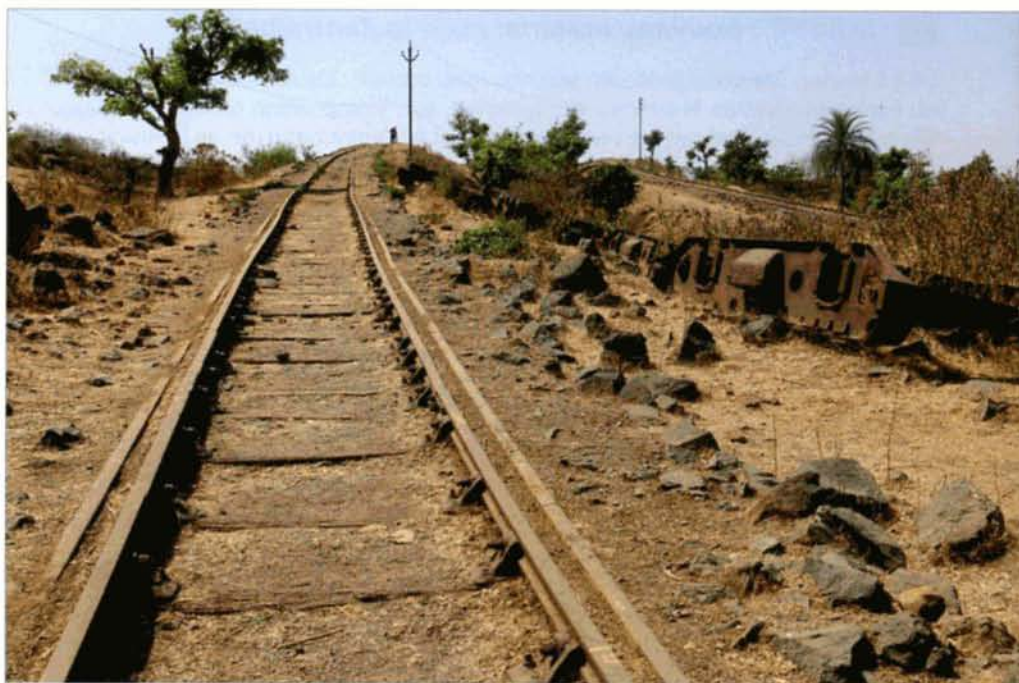
PHOTO 110-93 Le sommet de deux voies de secours. Plusieurs bogies de wagons sont visibles sur le côté. Bhima, 22 février 2012. Jean-Luc VANDERHAEGEN.
