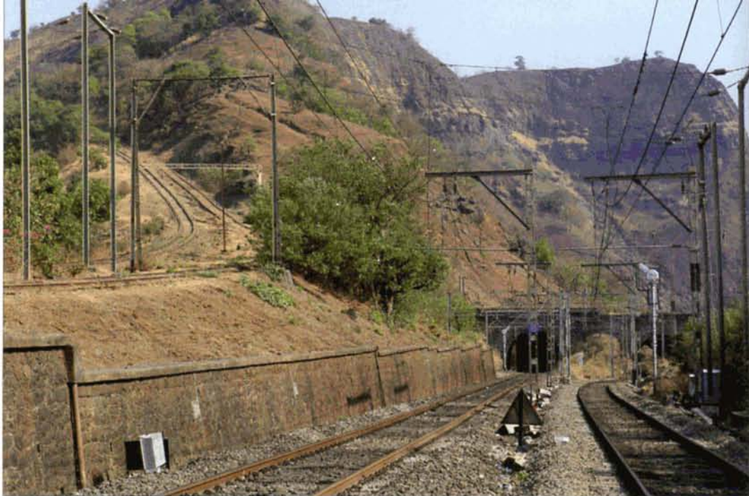
PHOTO 110-100 Les voies de secours de Monkey Hill (montagne des Singes). La ligne monte d'une altitude de 50 m à celle de 622 m en 26 km, soit une rampe moyenne de 22‰. Jean-Luc VANDERHAEGEN, 27 février 2012.
