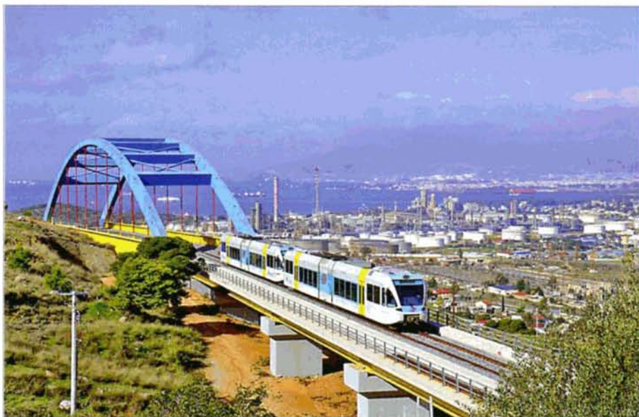
Pour l'inauguration de la nouvelle ligne, un train spécial a été mis en marche, composé des autorails OSE 560 904 et 560 914 (construction Stadler, type GTW 2/6). Nikos KOLONOS.
