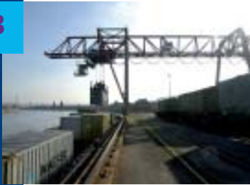
Le rail, allié des ports
