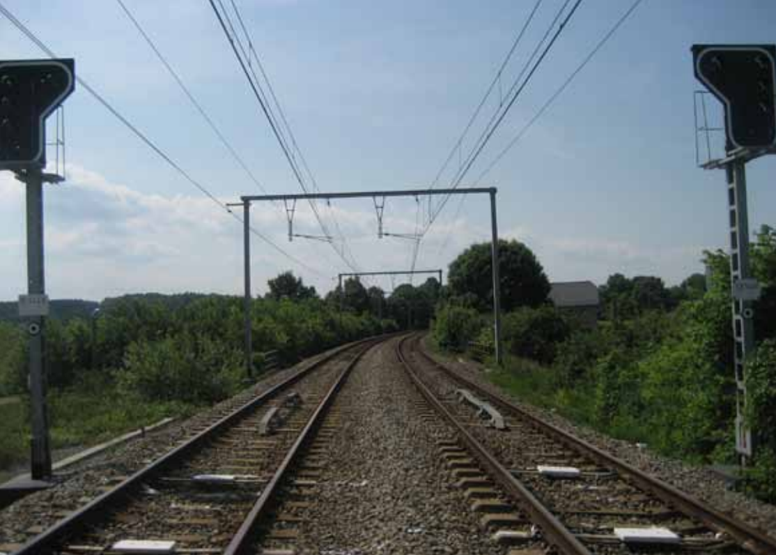
◀ Un crocodile et des balises ETCS et TBL1 placés dans les voies
