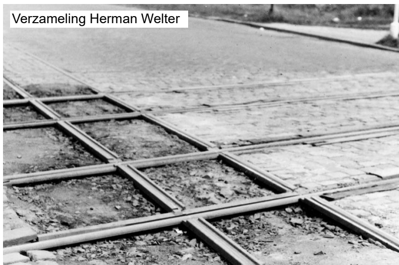
De gelijkgrondse kruising van het tramspoor met de dubbelsporige fortenlijn aan de Boomsesteenweg in Wilrijk (O.W. 22).
