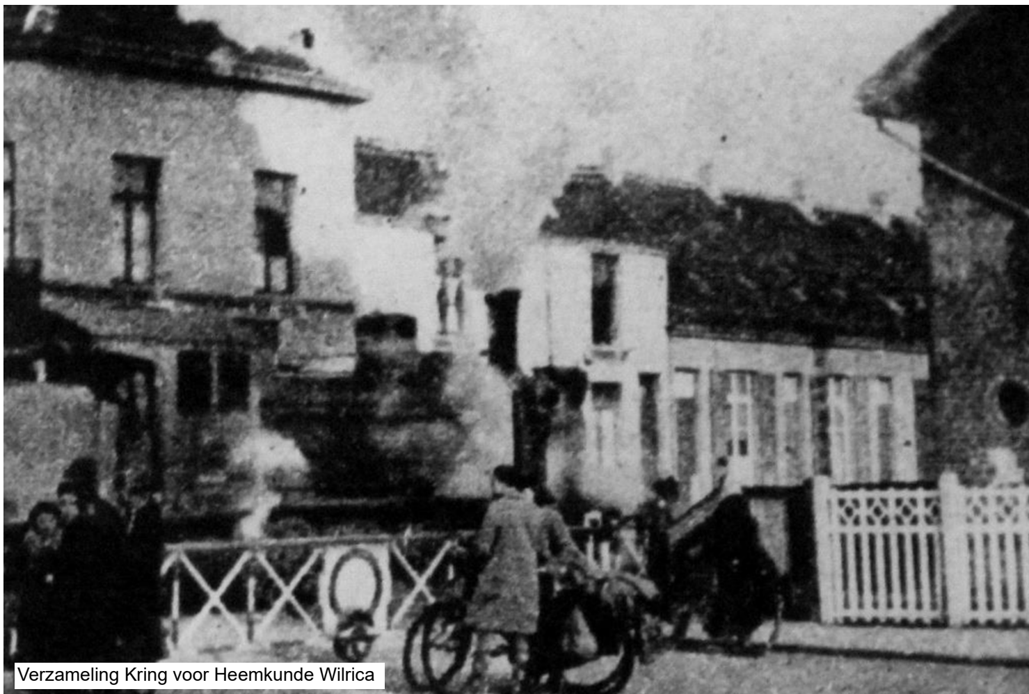
Overweg 23 met de Heistraat in Wilrijk in de jaren twintig (met rolbarelen). De stoomlocomotief is een type 71, vermoedelijk van de stelplaats Antwerpen-Zuid. Het is een ex-Pruisische G7 die krachtens het Wapenstilstandsverdrag van 1918 aan België was afgestaan. Foto: Kring voor Heemkunde Wilrica.
