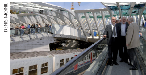
Ce 19 juin, l'Administrateur délégué Jannie Haek est venu visiter le site de la nouvelle gare en chantier, la gare provisoire et l'Espace Guillemins.
