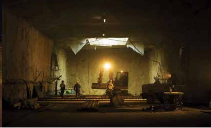
La taupe commencera le creusement à partir de ce puits
