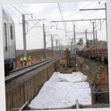
On place ensuite un géotextile (pour empêcher l'argile de remonter dans le ballast) que l'on recouvre de plusieurs couches de pierres.
