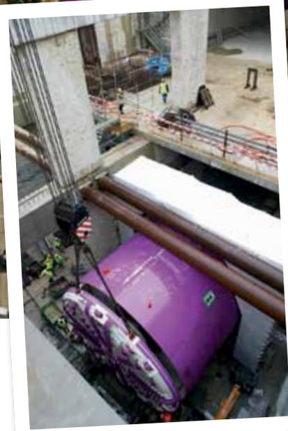
Le montage de la roue de coupe gigantesque du tunnelier dans son puits de départ.
