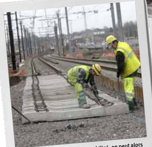
Une fois le ballast installé et stabilisé, on peut alors installer les traverses, voies et aiguillages...
