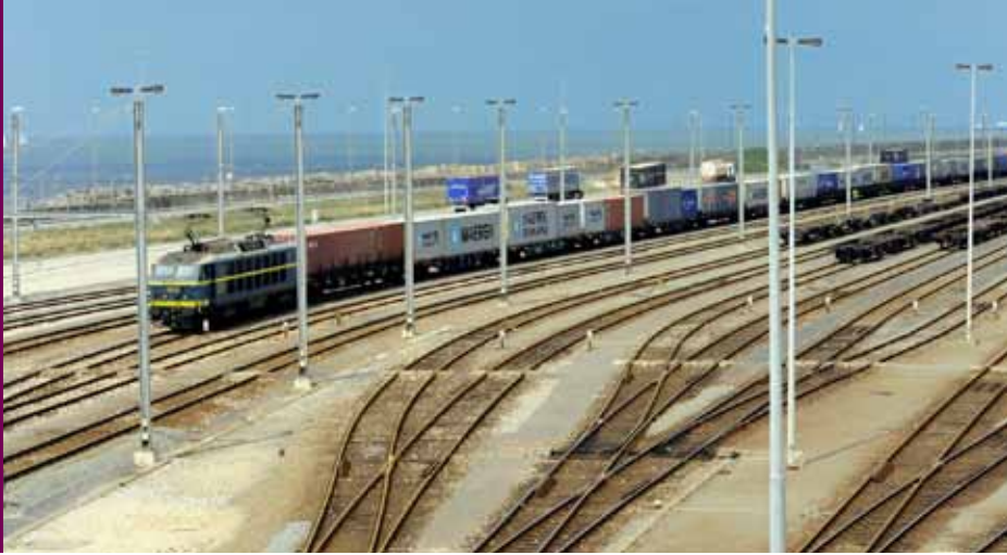
Le faisceau modernisé de Voorhaven-West.
