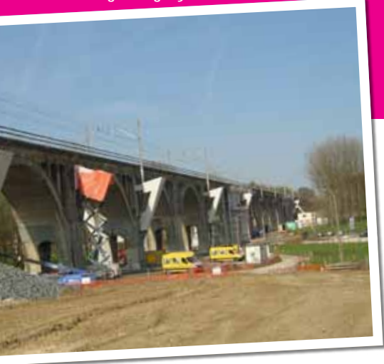
Le viaduc de la Pede à Pede-Sainte-Anne (Itterbeek) le long de la ligne 50A
