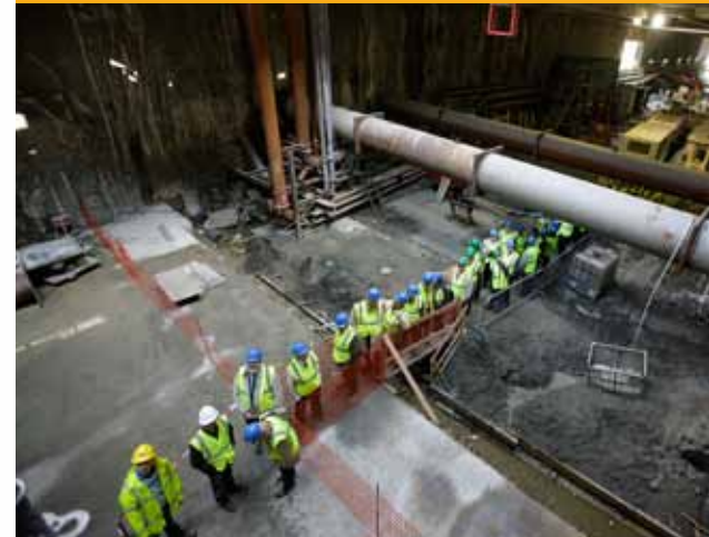
Les participants visitent le chantier de la liaison ferroviaire du Liefkenshoek
