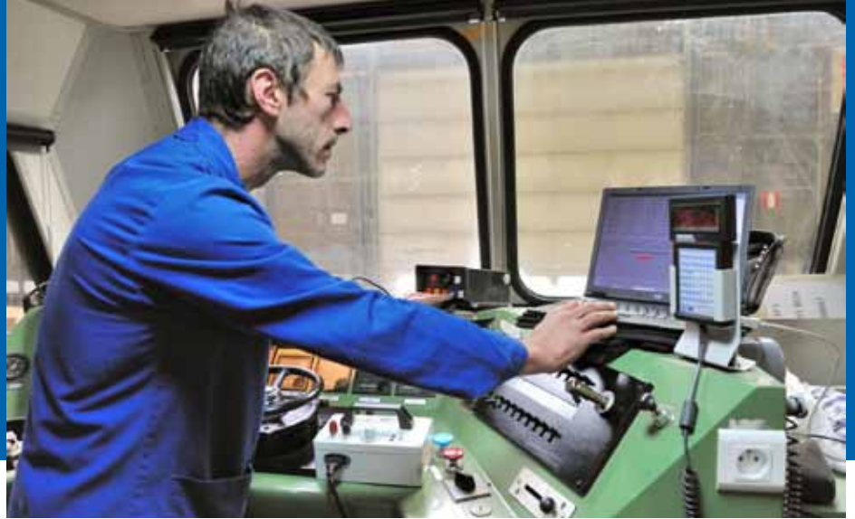
Hugues Ducarme teste les équipements TBL1+ installés à bord de la voiture pilote.
