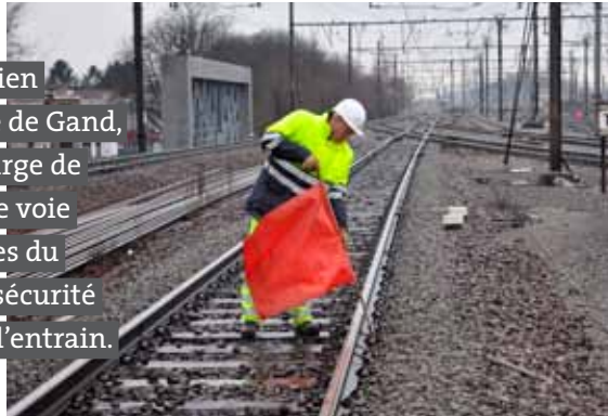
L'une des tâches essentielles de Patrick consiste à protéger les voies en plaçant des drapeaux rouges et des pétards.
