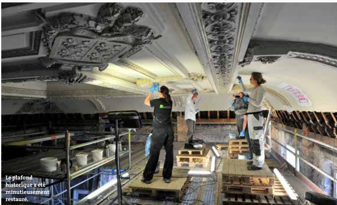
▲ La réparation des corniches et ornements muraux endommagés a exigé un travail de précision.
