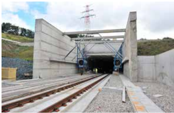
L'entrée du tunnel ferroviaire de Beveren sur la rive gauche.
