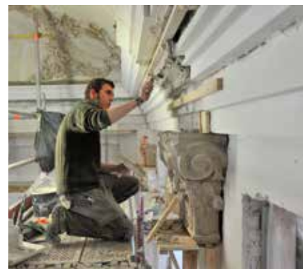
▲ La réparation des corniches et ornements muraux endommagés a exigé un travail de précision.
