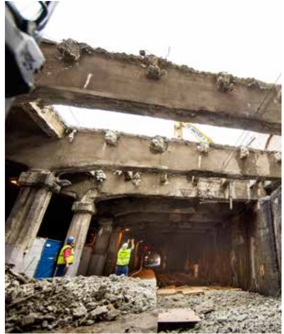
2.000 m 3 de voûte à démonter, soit pas moins de 2.000 tonnes de béton armé.
