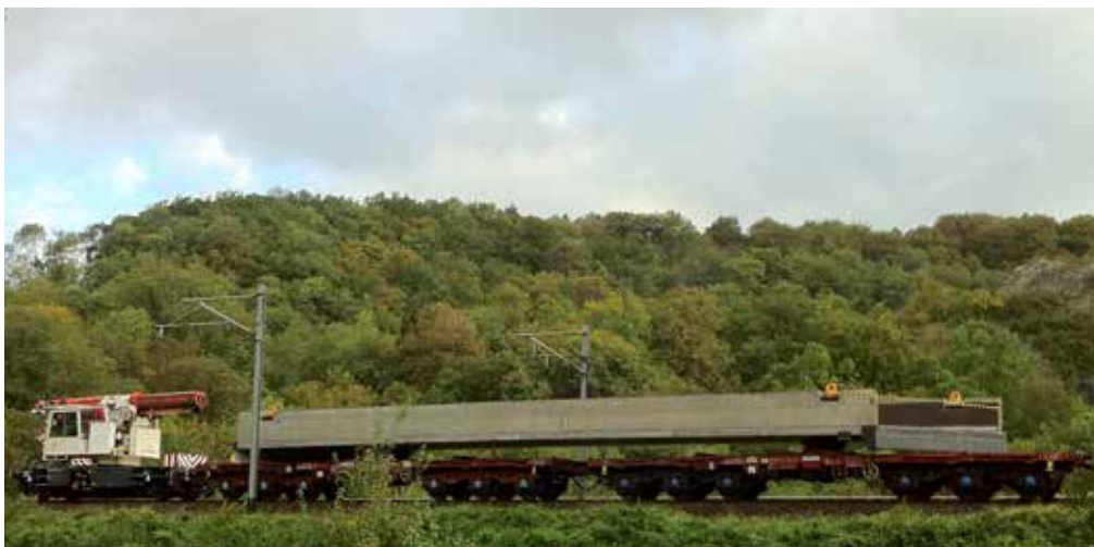
Acheminement par rail du nouveau pont 'Raborive' à Rivage, sur la ligne 42.
