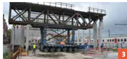
Les transbordeurs placent le pont sur les poteaux. Le 'Pont du Luxembourg' fait désormais partie de Train World.
