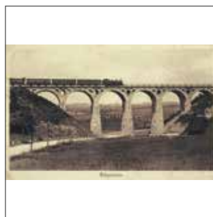
Le viaduc de Butgenbach.
