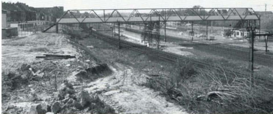
**PHOTO 18-47** La nouvelle passerelle de la gare de Hal. Celle-ci relie les deux gares provisoires visibles à l'extrême droite et gauche, et donne accès aux trois quais. La ligne TGV passera sous la partie gauche de la passerelle. Vue prise en direction de Mons le 19 avril 1994.
