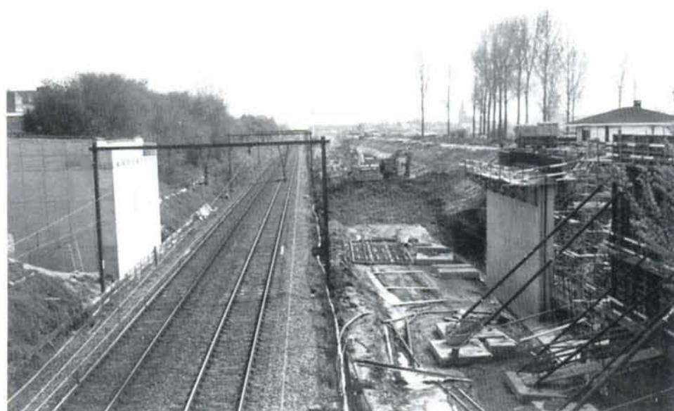
**PHOTO 18-54** La construction du nouveau pont entre Hal et Lembeek. On peut très bien distinguer l'état d'avancement du terrassement de la ligne TGV.
