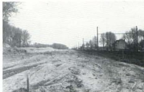
**PHOTO 18-43** Peu avant la gare de Lot, les premiers travaux de terrassement pour la future assiette de la ligne 96 et du viaduc de la ligne TGV montrent bien l'ampleur du chantier. C'est à cet endroit que la ligne TGV viendra s'intercaler entre les deux voies de la ligne 96 (vue prise en direction de Bruxelles); 19 avril 1994.
