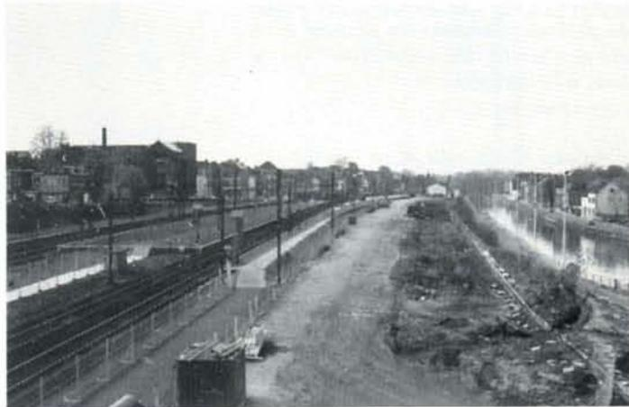
**PHOTO 18-46** *En gare de Hal, l'ancienne cour à marchandises est démontée et son hangar rasé. Sur cet emplacement sera aménagé le nouveau tracé de la ligne 94 et la pose d'une voie à quai supplémentaire; 19 avril 1994.*
