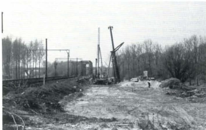
**PHOTO 18-51** Les travaux de fonçage de pieux pour les fondations du nouveau pont de la ligne 96 au-dessus du canal. A l'avant plan : le futur tracé de la ligne 96.
