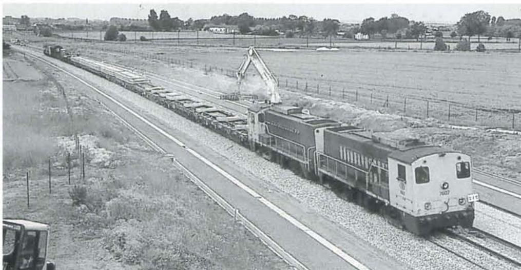
*Au départ de la voie 2, le train de traverses béton dépose son chargement dans la voie adjacente à l'aide d'une grue munie d'un palan. Hoves, 10 juillet 1996. Dia : Christian DOSOGNE.*
