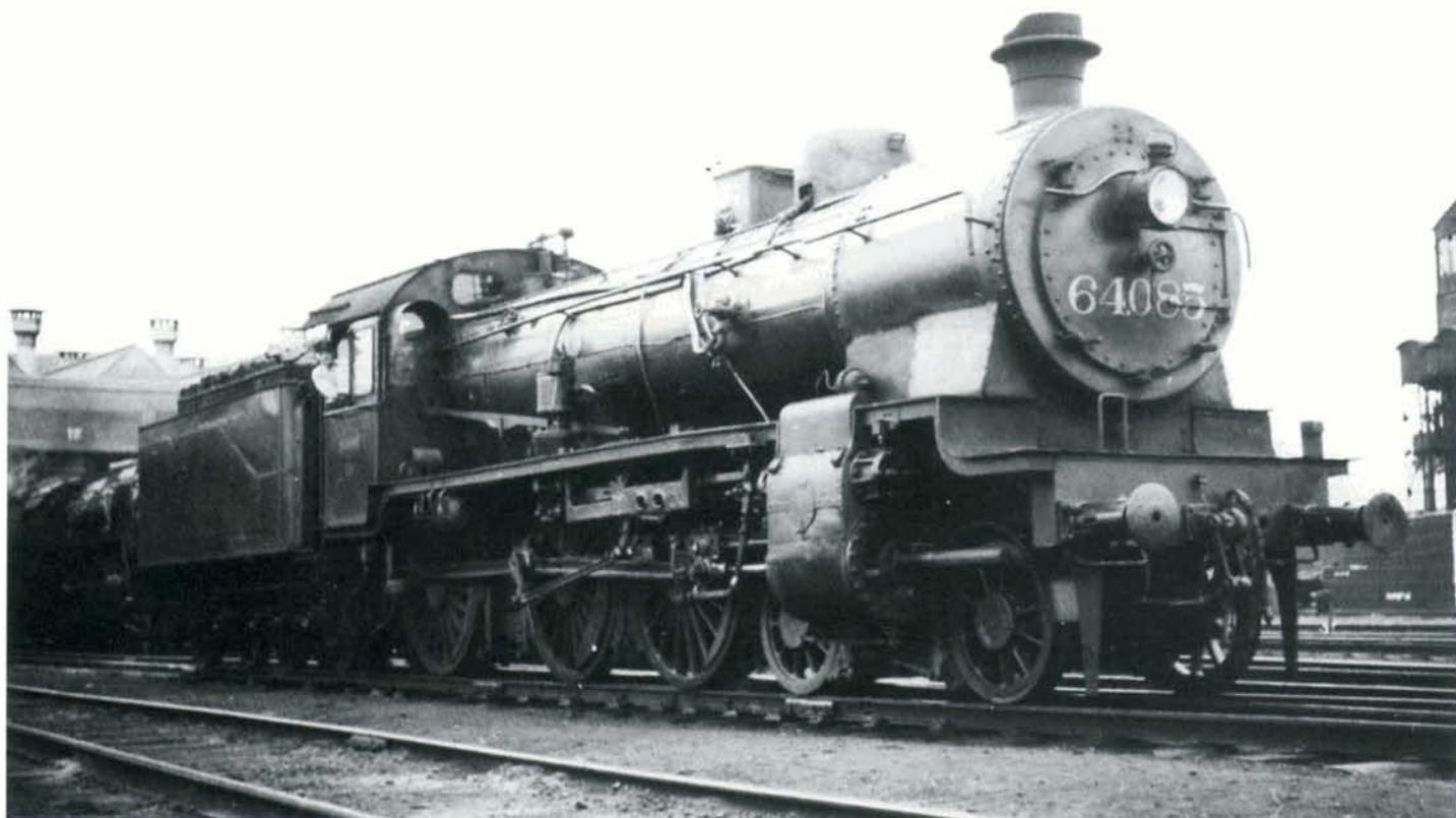
*La même locomotive photographiée au dépôt de Haine-St.Pierre, trente-trois années plus tard, le 9 mars 1952, accouplée au tender 22.219. On remarquera la grosse pièce en acier moulé supportant la coulisse et la glissière de tête du piston, indiquant qu'il s'agit d'une P8 de la seconde série. Collection : SNCB.*
