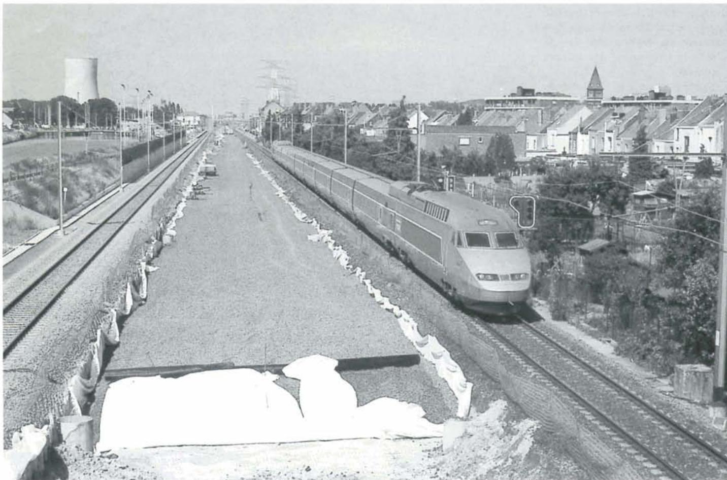
**PHOTO 27-53** *Entre Lot et Ruisbroek, la voie unique de la ligne 96A et la voie B de la ligne 96 ont été déposées pour laisser la place aux deux voies TGV. L'ancien ballast est enlevé et remplacé par un matériau neuf posé sur tissu géotextile. Ruisbroek, 22 juillet 1996. Photo : B. DIEU.*
