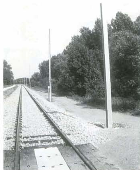
L'état d'avancement de l'électrification de la ligne 52 entre Boom et Puurs, le 16 juin dernier. Photo : William BOECKX.
