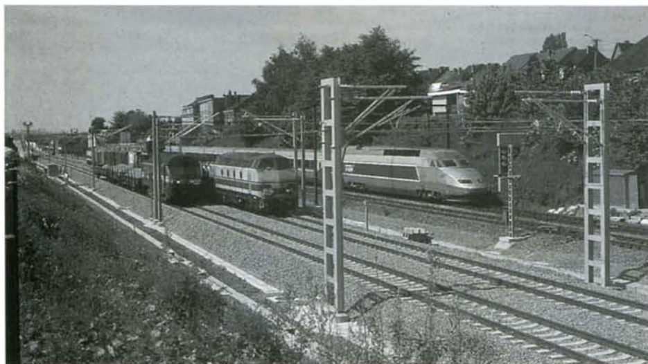
Deux trains de travaux opèrent à hauteur du « sas » électrique, là où le 25kV de la LGV fait place au 3000V =. Une 59 et une 62 affectées aux travaux TGV croisent un TGV « Réseau » qui se dirige vers Bruxelles. Lembeek, 26 mai 1997. Photo : C. DOSOGNE.
