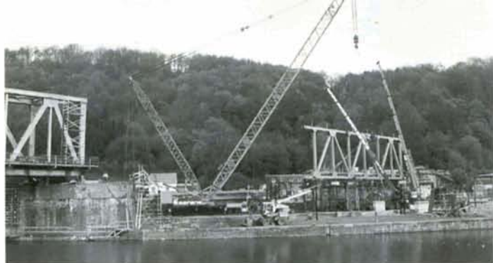
Vue d'ensemble des travaux de rénovation du viaduc d'Anseremme. Le pont-rail au-dessus de la ligne 154 est remplacé, ainsi que la première travée du viaduc métallique. 30 avril 1997. Photos : Tanguy BADIE.
