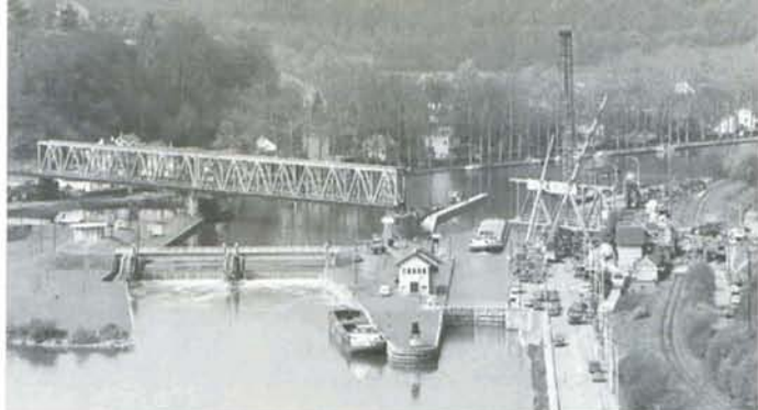
Vue d'ensemble des travaux de rénovation du viaduc d'Anseremme. Le pont-rail au-dessus de la ligne 154 est remplacé, ainsi que la première travée du viaduc métallique. 30 avril 1997. Photos : Tanguy BADIE.
