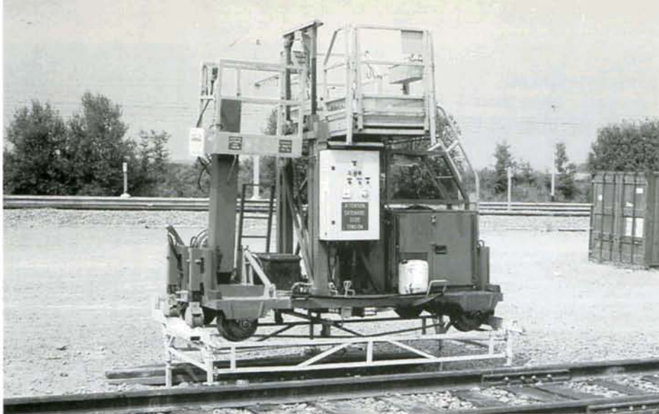
PHOTO 31-52 La ligne nouvelle est également parcourue par d'étranges engins autonomes, tel ce «P.A.I.C.» pour «Plate-forme autonome d'intervention caténaire» destiné à procéder aux réglages de la caténaire. Le véhicule peut être déraillé facilement et peut rouler par ses propres moyens à 5km/h... Base du Coucou, 4 juillet 1997. Photo : Baudouin DIEU.
