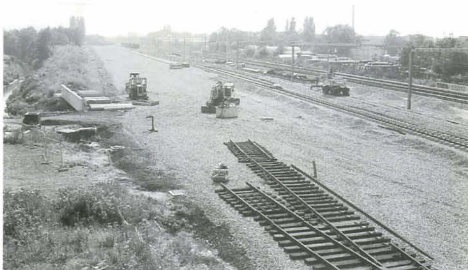
PHOTO 31-53 Le nouveau faisceau Volkswagen à hauteur de Ruisbroek est en construction. Les trains de travaux y sont amenés par le futur aiguillage de sortie côté Halle. Ruisbroek, 3 août 1997. Photo : Baudouin DIEU.
