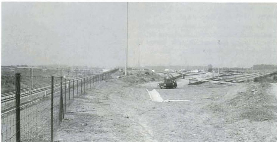
PHOTO 31-50 C'est ainsi que se présente l'ancien départ de St-Druon vers la ligne nouvelle : la voie arrive au nouveau talus, limitée par un heurtoir. Saint-Druon, 4 août 1997. Photo : Baudouin DIEU.
