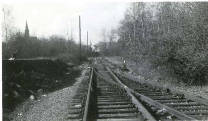
La ligne 31 partiellement démontée à la sortie d'Ans-Est à hauteur de l'ancien raccordement de la gare. On remarquera que les poteaux supports de caténaire sont toujours debout! Mars 1997.
