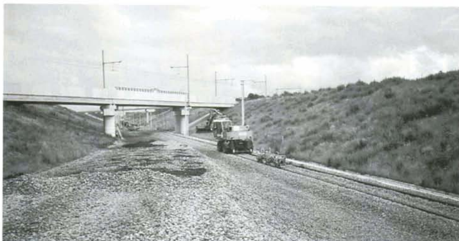
PHOTO 31-51 Divers engins spéciaux peaufinent le travail, tel ce train allemand de meulage des rails SCHEUCHZER au travail sur le viaduc du Try-Bas. Saintes, 1er août 1997. Photo : Baudouin DIEU.
