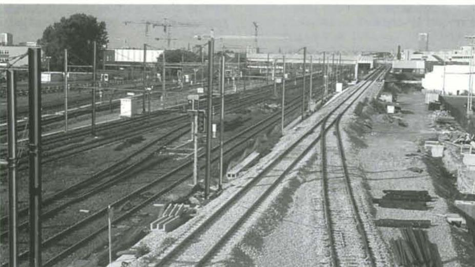
**Vue du chantier prise du pont de l'autoroute à Drogenbos vers Bruxelles. A droite, la voie A de la ligne 96A descend du viaduc. L'accès au faisceau Volkswagen est matérialisé par l'aiguillage visible à l'avant-plan. Entre les deux voies de la ligne 96 viendront se placer les deux voies TGV. Forest, 30 août 1997. Dia : C. DOSOGNE.**
