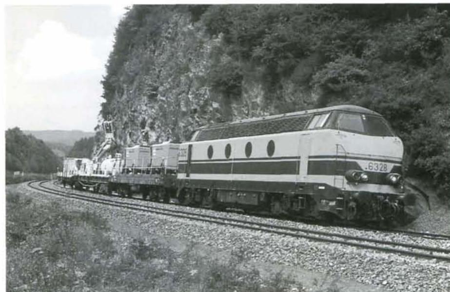
PHOTO 32-47 Le 7 août 1997, un train de travaux remorqué par la 6328 assure le forage des trous dans la roche, dans la célèbre courbe de Cierreux. Photo : Philippe DIEU.
