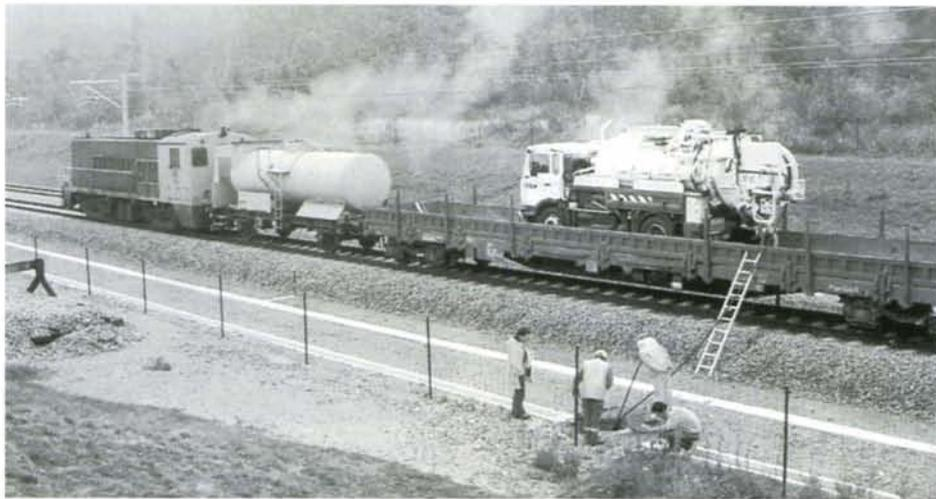
**PHOTO 32-61** Le train TELEREP en action à hauteur de la base du Coucou : du camion part un flexible qui projette l'eau à 150 bars dans le tuyau de drainage dont on aperçoit l'ouverture. Au crochet de la locomotive, la citerne de 18.000 litres du PFT. Meslin-l'Évêque, 19 septembre 1997. Photo : Baudouin DIEU.
