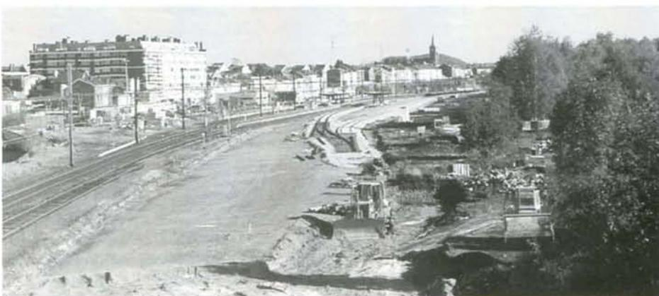
**PHOTO 32-70** La gare de Ans vue vers Liège. La pose des futures voies 4 et 5 a commencé. La base de maintenance prendra place à l'emplacement de l'ancien faisceau marchandises. Ans, 23 octobre 1997. Photo : Baudouin DIEU.
