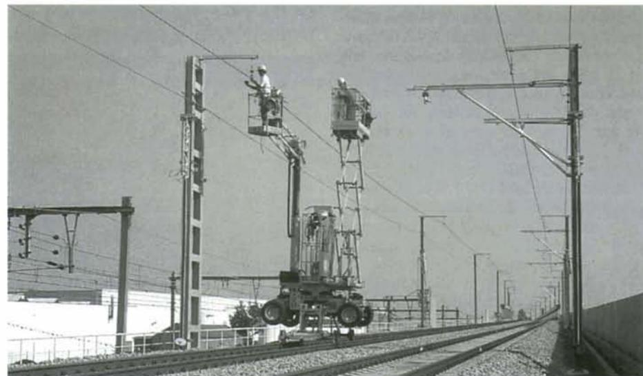
Dénommée "Lama" par ses utilisateurs, cette plate-forme autonome est utilisée par la firme française SCLE pour le réglage de la caténaire. Elle est photographiée en position haute et déployée sur le viaduc de Lot le 3 septembre; cet engin peut être déraillé en cinq minutes environ. Dia : Christian DOSOGNE.
