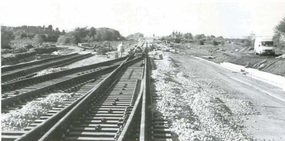
**PHOTO 32-69** La ligne 36 photographiée à hauteur de la bifurcation de Voroux vers Fexhe. A l'avant-plan, la ligne 36A venant de Kinkempois. A gauche, la nouvelle voie de desserte de l'atelier des wagons. Au fond, les appareils d'accès à la base de travaux. Voroux, 23 octobre 1997. Photo : Baudouin DIEU.
