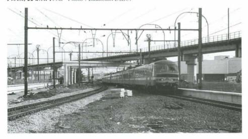
PHOTO 34-45 En gare de Forest, la nouvelle voie B de la ligne 96 se raccorde à l'ancienne, par un tracé qui permet maintenant le passage à 90 km/h. Un train IR de la relation Schaerbeek-Binche passe à cet endroit. Forest, 22 avril 1998. Photo: B. DIEU.
