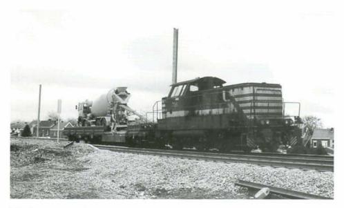
PHOTO 34-47 Le bétonnage des poteaux caténaires de la ligne 36N entre Ans et Fexhe est assuré par un mixer routier placé sur un wagon plat. La 7381 de Kinkempois assure la remorque de ce train pour le moins singulier. Bierset, 20 avril 1998. Photo: Baudouin DIEU.
