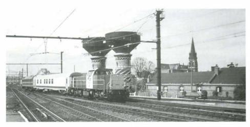
PHOTO 34-20 • et 34-21 • Dans le cadre de la l'étude des futures locomotives de la série 77, des parcours d'essais de stabilité ont été réalisés avec la locomotive 6459 des NS, entre Antwerpen-Oost et Ekeren le 9 avril 1998. La rame était composée de la 6459, de la voiture de mesure 0601 et de la locomotive-musée 201.010. Ci-dessus à Antwerpen-Oost, ci-dessous à Ekeren. Photos: Yvo VAN STEENWINKEL.
