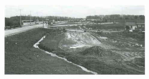
PHOTO 34-49 A Bettincourt, à hauteur de la station-service autoroutière, les travaux avancent également. La voirie locale est en cours de déviation pour permettre la construction des ouvrages d'art qui permettront au TGV d'être en tranchée. 21 avril 1998. Photo : Baudouin DIEU.
