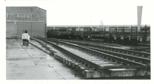
L'Atelier Central de l'Infrastructure de Bascoup a prémonté le tout premier appareil de voie SNCB monté sur des traverses en béton. Il sera ultérieurement posé en gare de Trois-Ponts. Bascoup, 3 avril 1998. Photo: Jacques DELFORGE.
