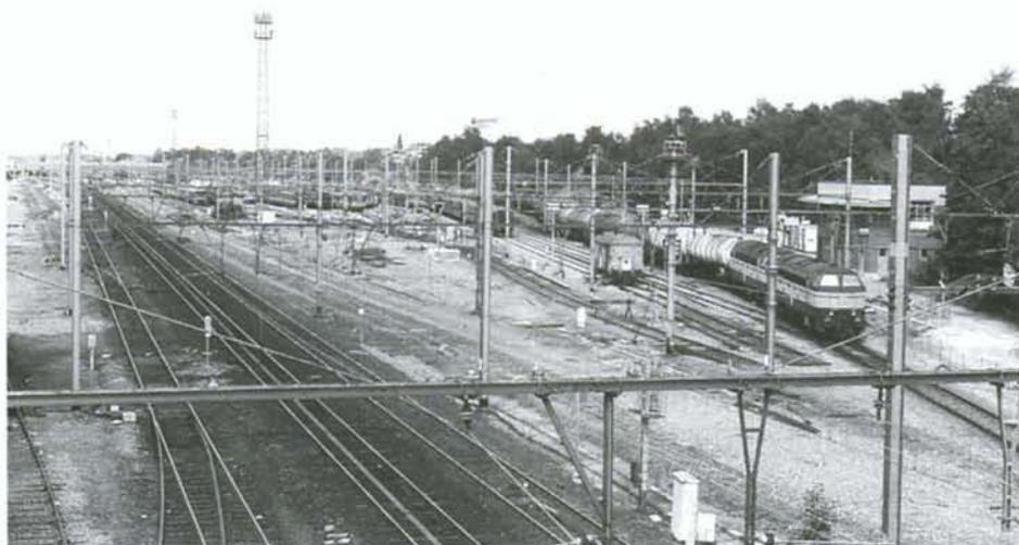
**PHOTO 35-71** Vue générale de la gare de Leuven prise vers Bruxelles. A gauche, la voie est utilisée dans les deux sens par les trains de voyageurs de la ligne d'Ottignies; au centre, les deux voies de la ligne 36. A droite, l'accès au faisceau Q est supprimé; tous les trains de marchandises ont le relais reporté à la formation côté Bruxelles. Leuven, 17 août 1998. Photo : Baudouin DIEU.
