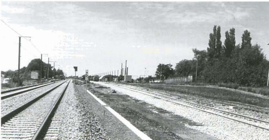
PHOTO 35-75 Les travaux à hauteur du futur point d'arrêt de Voroux, sur la ligne 36 nouvelle. A gauche, les deux voies de la ligne 36; à droite, la voie d'accès et la voie de départ de la future base, dont le faisceau de réception se trouve dans le fond (les poteaux caténaires y sont encore présents!). A l'extrême droite, l'ancienne bosse de triage, avec sa loge et l'éclairage... Voroux, 17 août 1998. Photo : Baudouin DIEU.
