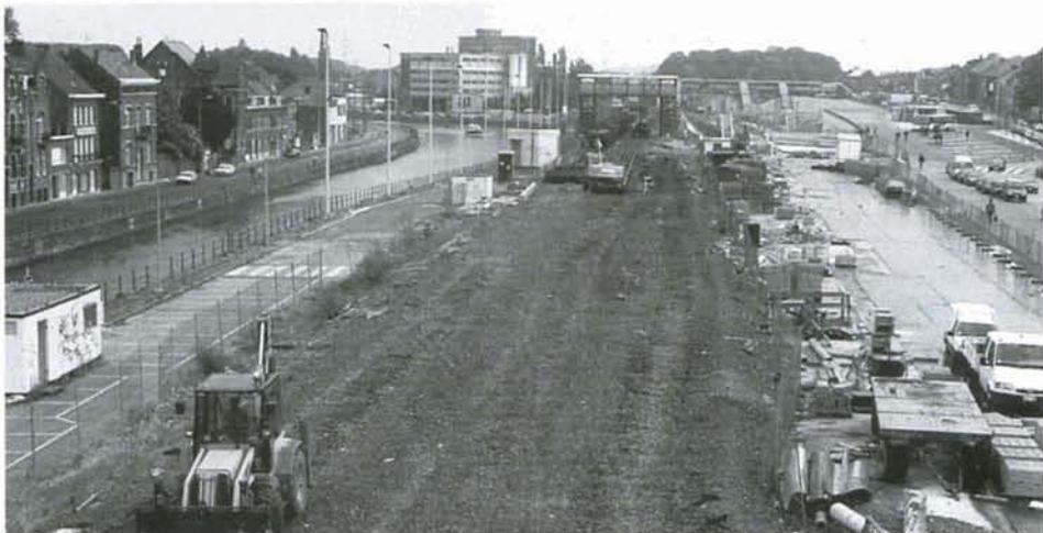
Une dernière vue de ce que furent les travaux de Halle : le démontage de la gare provisoire est terminé. Là où il y eut à un certain moment sept voies, il ne reste qu'une dalle de béton... Halle, 27 mai 1998. Dia : Christian DOSOGNE.
