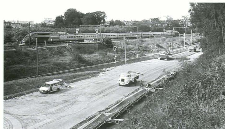
**PHOTO 36-33** Les travaux à la bifurcation "Tivoli" en gare de Leuven côté Liège. La plate-forme à l'avant-plan recevra la voie A de la ligne 36/2 (départ des faisceaux vers Liège) ainsi qu'un cul-de-sac de manoeuvre. Leuven, 2 octobre 1998. Photo : B. DIEU.
