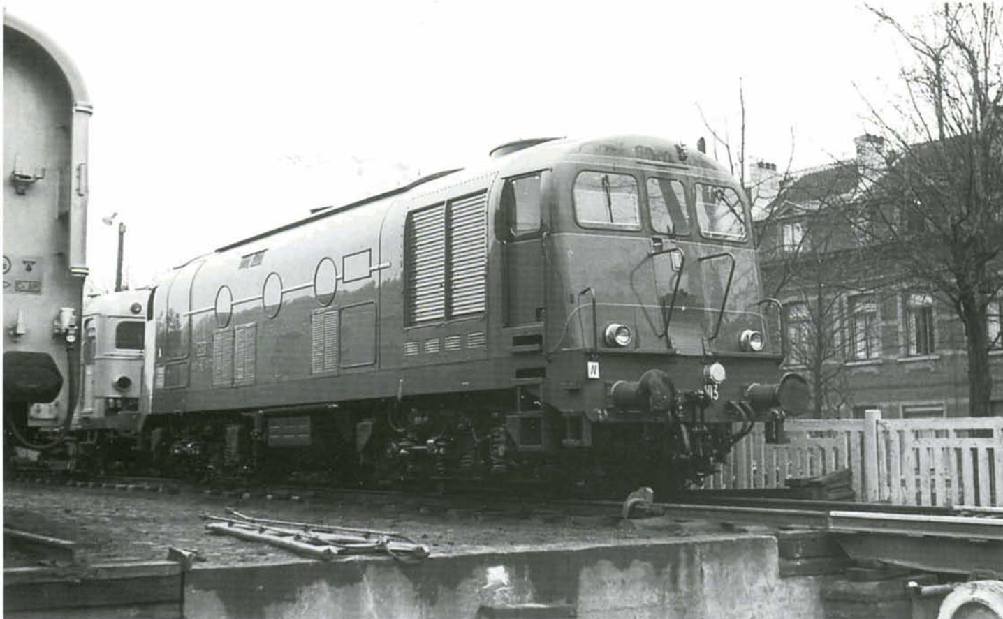
**PHOTO BD-049** Le 19 février 1958 en gare de Jette, la locomotive Diesel italienne D341.103 des FS, attend son transport vers le Heyssel. Ce type de locomotives a été livré à 16 exemplaires (D341.101 à 116 puis D341.1001 à 1016) par différents constructeurs (Fiat, TIBB, Regiane, OM, Pozzuoli) de 1957 à 1959. Elles étaient pourvues d'un moteur Diesel de 1320 CV et d'une transmission électrique. D'une masse de 66,5 t, les dernières D341.1000 ont été radiées par les FS vers la fin des années '80.
