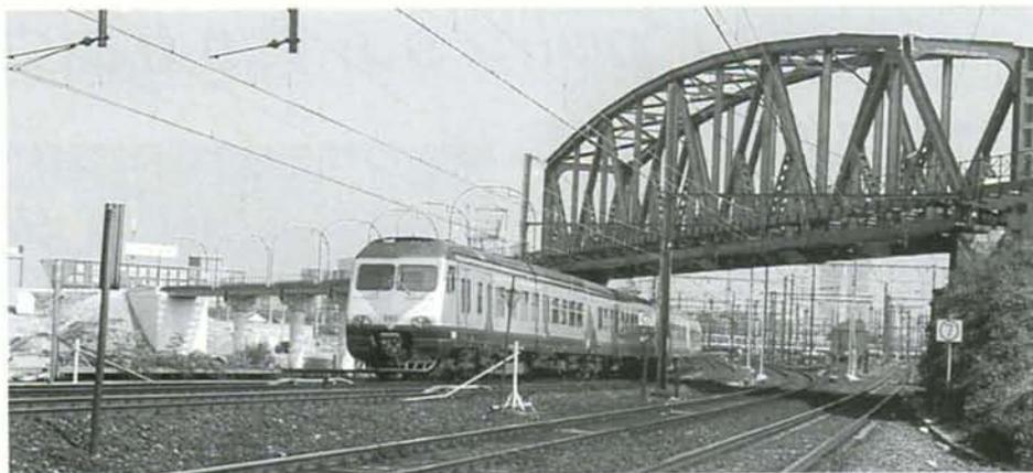
**PHOTO 36-31** A l'entrée de Bruxelles-Midi, le pont de la ligne 28/3 qui enjambe les lignes 96 et 50A a été rehaussé et remis en état. A gauche, le prolongement par un ouvrage en béton. Forest, 28 septembre 1998. Photo : Baudouin DIEU.
