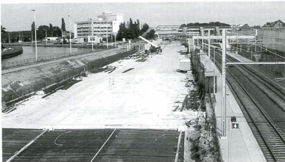
**PHOTO 36-28** La gare de Halle vue vers Bruxelles. Le radier des voies 1 (trains vers ligne 26) et 2-3 (voies de la ligne 94) est en voie d'achèvement. A gauche, le canal Bruxelles-Charleroi. Halle, 30 septembre 1998. Photo : Baudouin DIEU.
