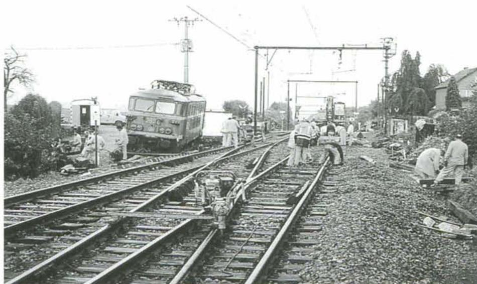
**PHOTO 36-11** Afin d'accélérer la remise en état de la voie, la 2632 a simplement été poussée hors des voies. Sa remise sur rail s'est opérée un mois plus tard, la nuit du 11 au 12 octobre 1998. Photo : Alain DEFECHEREUX, 13 septembre 1998.
