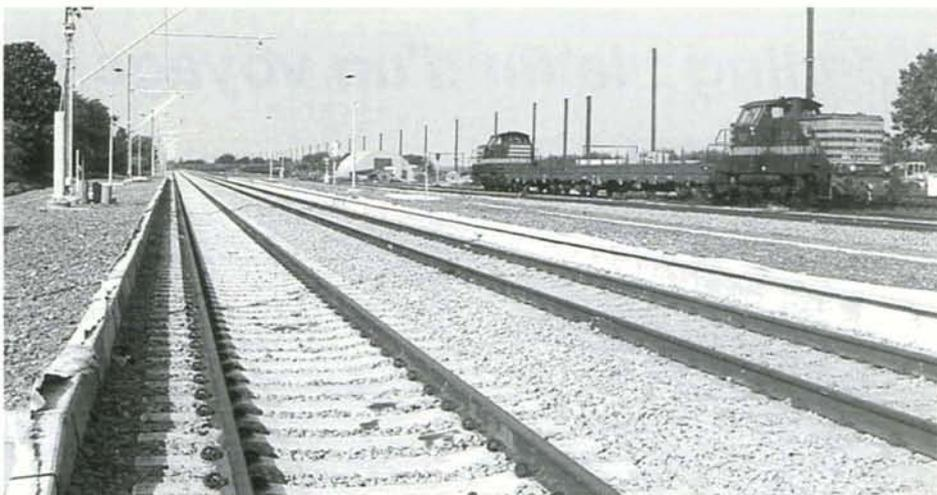
**PHOTO 36-36** Vue du nouveau point d'arrêt de Voroux sur la ligne 36 rectifiée. La voie B est pratiquement achevée, tandis que la voie A doit encore être électrifiée. A droite, les machines affectées aux travaux d'électrification de la ligne 36N. Voroux, 30-09-1998.
