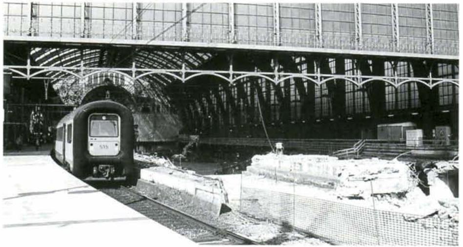
La situation en gare d'Antwerpen-Centraal, où les voies 1 à 3 sont exploitées. A droite, le creusement de la gare souterraine, actuellement au niveau -1. Antwerpen-Centraal, 29 mars 1999. Photo : Marc GRIETEN.
