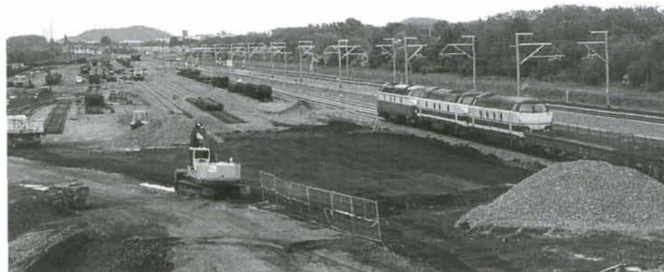
**PHOTO 38-71** La base de travaux de Voroux vue depuis le block 5. Un train de matériel vide se dirige vers la sortie; les trois machines sont justifiées par la charge à la montée, transitant par les plans inclinés. Voroux, 11 mai 1999. Photo : Baudouin DIEU.
