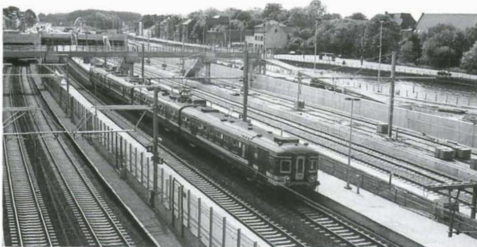
**PHOTO 38-62** La gare de Halle dans sa configuration définitive; sept voies, dont cinq à quai, spécialisées par ligne permettront un important trafic de voyageurs, drainé par au moins trois accès (deux passerelles et un accès direct de la future gare). A gauche, les deux voies TGV, à l'extrême droite, la voie d'où partiront les trains de la ligne 26. Halle, 11 mai 1999. Photo : Baudouin DIEU.
