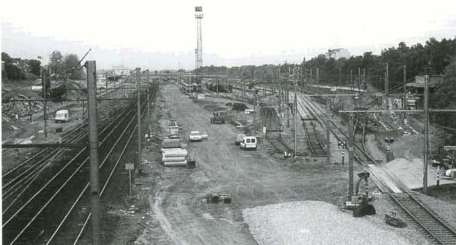
**PHOTO 38-68** Vue de la gare de Leuven, prise du pont de la route de Tienen. A droite, les nouvelles voies d'accès aux faisceaux marchandises et de garage; au centre, les travaux de renouvellement de la banquette des futures voies A de la ligne TGV et de la ligne 36. Leuven, 11 mai 1999. Photo : Baudouin DIEU.
