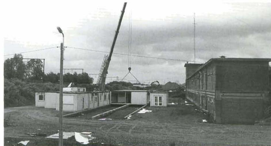
**PHOTO 38-72** Installation des modules de chantier entre la ligne 36 ancienne à gauche et les bâtiments de service à droite; dans le fond, en surélévation, le block 5 de type électrique ACEC, qui disparaîtra vers le mois de septembre. Voroux, 11 mai 1999. Photo : Baudouin DIEU.
