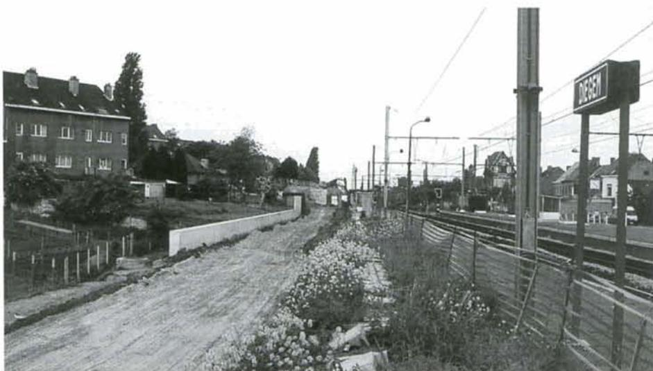
**PHOTO 38-65** La gare de Diegem. A gauche, l'emplacement pour la future voie vers Bruxelles de la ligne 36 dont les talus sont confortés par un mur de soutènement. Diegem, 11 mai 1999. Photo : Baudouin DIEU.
