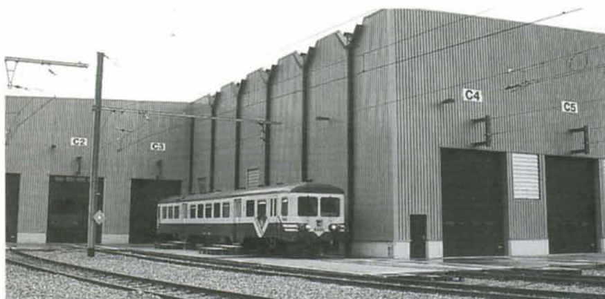
PHOTO 40-52 Lors du week-end commémorant les 125 ans du bâtiment de la gare de Charleroi-Sud, le 4406 fut utilisé pour effectuer des navettes entre cette gare et le nouvel atelier de traction de Charleroi-Sud-Quai, dans le cadre de portes ouvertes. Photo : Marc GRIETEN.
