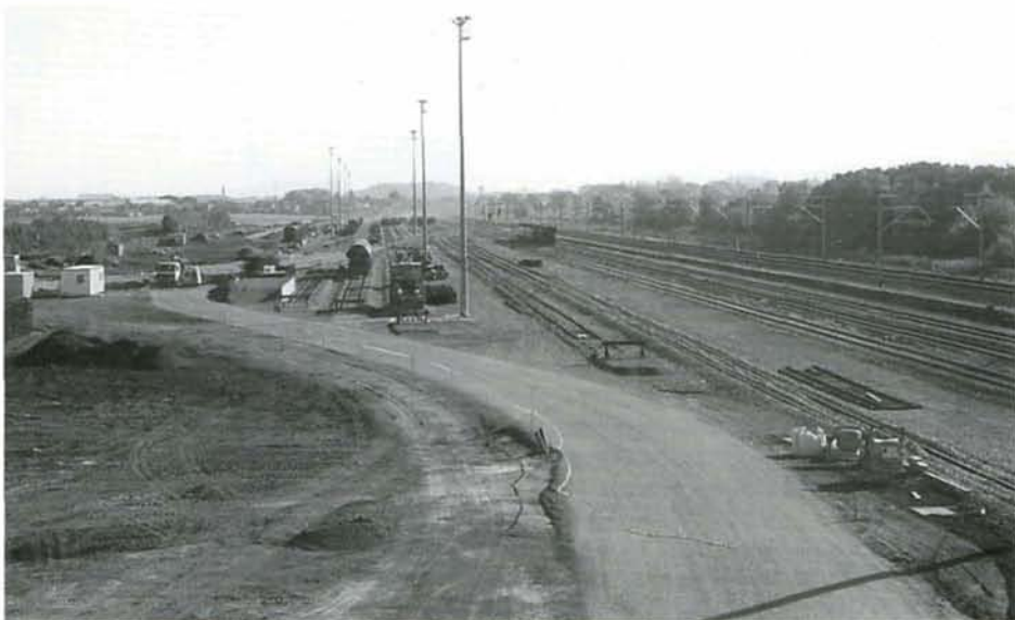
PHOTO 40-69 La base de Voroux côté Liège. De droite à gauche, la ligne 36 rectifiée, les voies d'accès à la base, les faisceaux de garage des engins d'entreprise. Dans le fond, le faisceau "formation". Voroux, 11 octobre 1999. Photo : Baudouin DIEU.
