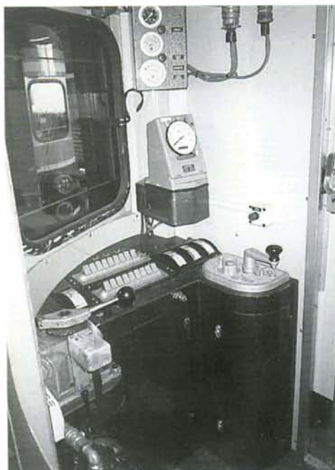
Une cabine de conduite de la 149, vue après son déplacement de la droite vers la gauche.
