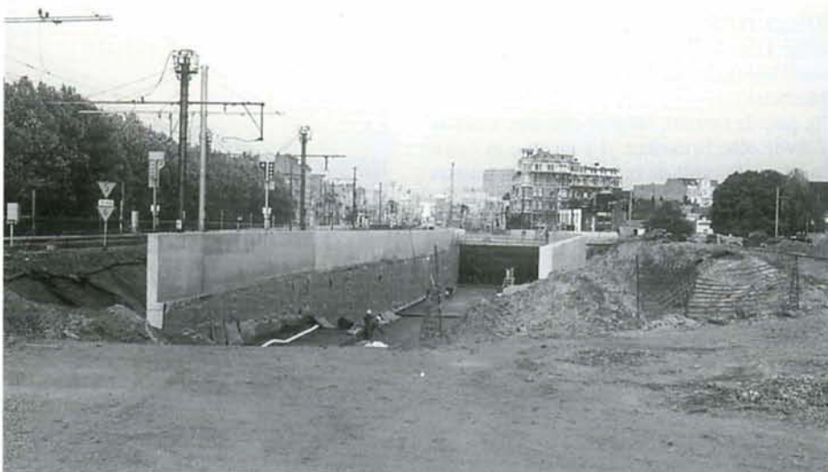
PHOTO 40-68 Berchem, 20 octobre 1999. C'est de chaque côté de ces murs que les voies descendront vers le niveau inférieur. L'espace doit être comblé pour permettre la pose des voies qui donneront accès à la gare de surface. Photo : Baudouin DIEU.
