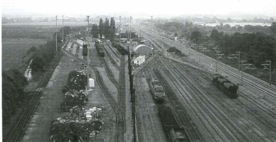
La base de Voroux photographiée du haut d'un mât d'éclairage le 15 octobre 1999. A l'avant-plan à gauche, le dépôt des locomotives; à droite, le faisceau de réception. Les faisceaux "formation" et "entreprises" se situent dans le fond. Document : TUC RAIL.
