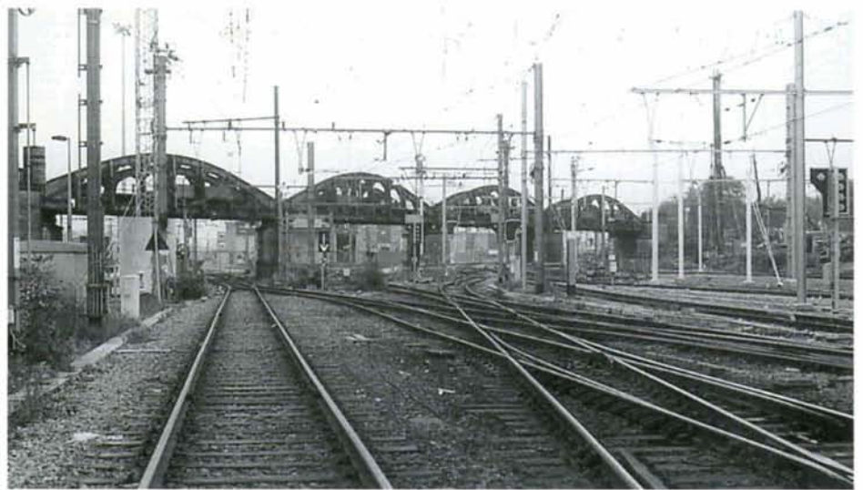
PHOTO 40-67 Le remplacement des ponts métalliques Vierendeel se poursuit entre Forest-Midi et Bruxelles-Midi. Les piles qui supporteront la travée centrale, métallique, se positionnent de part et d'autre des voies. Forest, 28 octobre 1999. Photo : B. DIEU.
