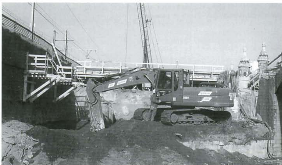
PHOTO 40-70 Entre Berchem et Antwerpen-Centraal, les engins de chantier travaillent entre les murs existants. On aperçoit à droite un pont de briques qui a été scié! Berchem, 20 octobre 1999. Photo : Baudouin DIEU.
