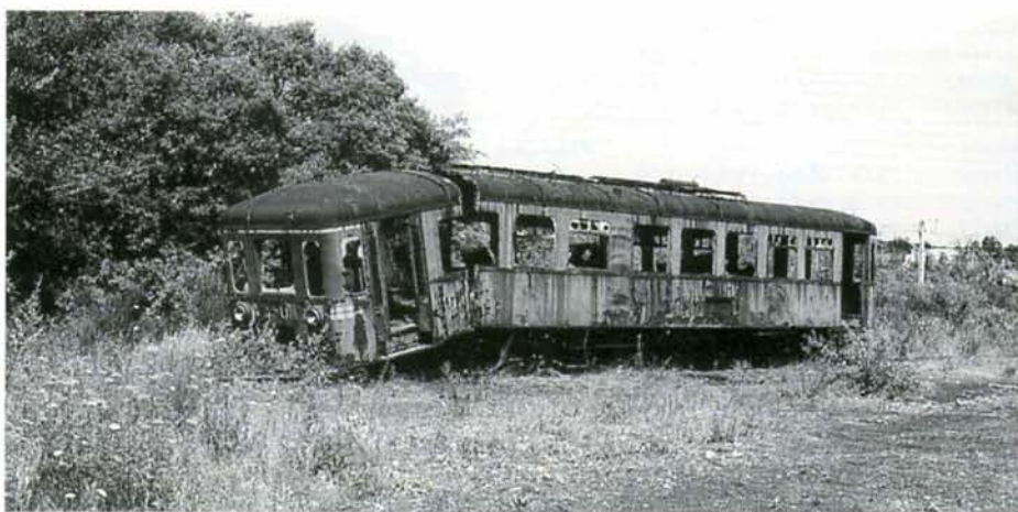
PHOTO 40-48 Le 4901 garé dans l'enceinte de l'ancien atelier de Latour depuis plus d'une dizaine d'années, a été ferrailé à la fin du mois de juillet. Vu son état de délabrement, une restauration s'avérait impossible à réaliser. Le PFT a récupéré ce qui pouvait encore l'être, notamment des organes de la transmission et du moteur Diesel. Latour, 30 juillet 1999. Photo : Pierre HERBIET.
