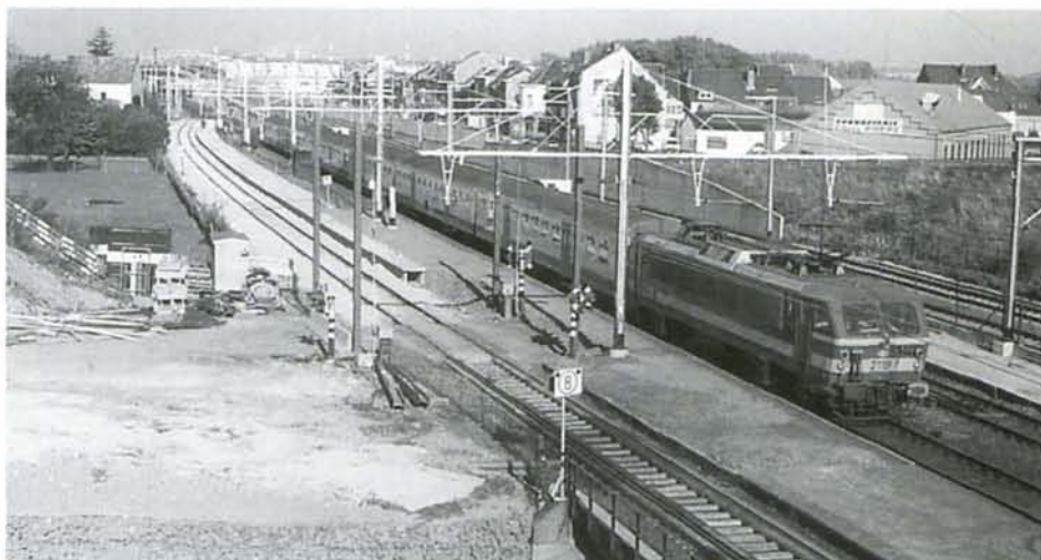
PHOTO 40-66 La ligne 96 E est remise en service à Lot, avant le remplacement des ponts métalliques sur la Senne. Lot, 22 octobre 1999. Photo : Baudouin DIEU.
