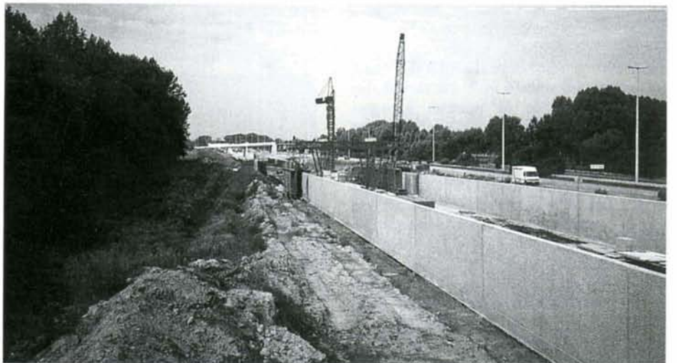
Les travaux à hauteur de la station-service de Bettincourt, le long de l'autoroute E40. Les murs de soutènement se construisent simultanément des deux côtés grâce à un portique spécial. Bettincourt, 24 août 1999. Photo : Armand THONET.
