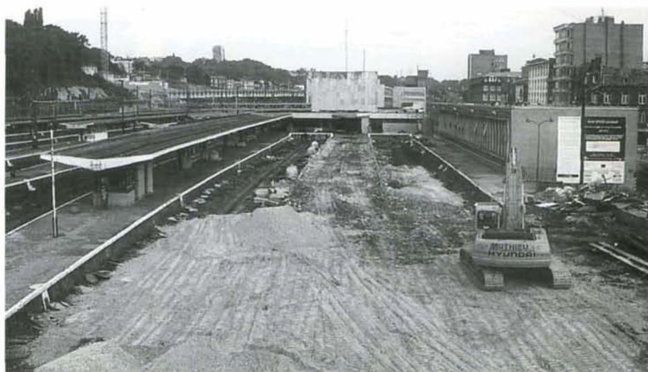
La gare latérale des Guillemins en cours de démontage. Liège, le 19 septembre 1999. Photo : Roger CRICELAIRE.
