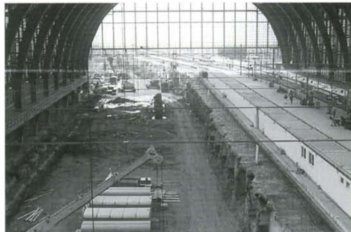
PHOTO 40-72 Vue générale des travaux prise du sommet de la verrière le 20 octobre 1999. Photo : B. DIEU.
