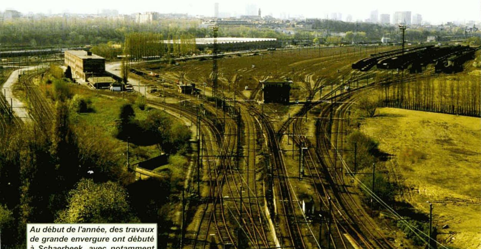
*Au début de l'année, des travaux de grande envergure ont débuté à Schaerbeek, avec notamment le démontage des deux grands faisceaux de triage A et B, pour permettre, non seulement, le passage des nouvelles lignes 25 et 36, mais également de préparer le terrain pour le RER et la construction projetée d'un second terminal TGV. D'ici 10 ans, la physionomie et le rôle de la gare de Schaerbeek auront radicalement changé.*
