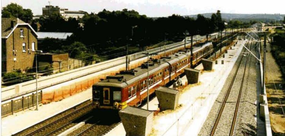
← **PHOTO 47-82** A Herent, les quais sont accessibles par le nouveau couloir sous-voies, mais la passerelle permet encore des vues aériennes... La nouvelle voie A est posée et la future voie B électrifiée. Bientôt, les voies médianes disparaîtront pour permettre leur renouvellement. B. DIEU, 17 juillet.
