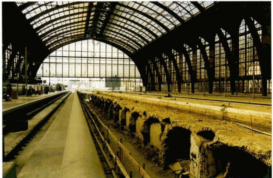
**PHOTO 47-89** L'intérieur de la gare d'Antwerpen-Centraal. A gauche, les voies 4 à 6 sont en service; à droite, les voies 1 à 3 sont hors service et déjà désélectrifiées. Au milieu, un puits de lumière permettra l'éclairage naturel du niveau inférieur. B. DIEU, 23 juillet 2001.
