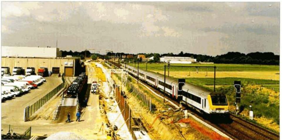
**PHOTO 47-81** Le raccordement D'Ieteren a été réaménagé, avec trois nouvelles voies. Un mur de soutènement le sépare de la future ligne 36 portée à quatre voies. Marc GRIETEN.
