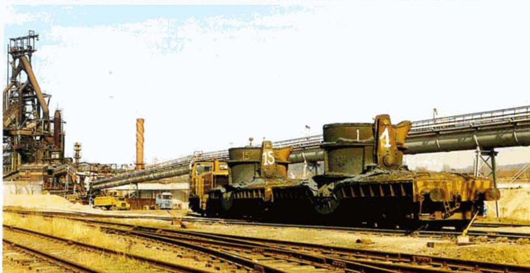
PHOTO 49-53 La fonte en fusion était acheminée entre le haut fourneau et l'aciérie à l'aide de poches posées sur d'énormes wagons à six essieux. L'aciérie était située sur une colline à l'ttre, de l'autre côté du canal, à environ un kilomètre du haut fourneau. Pour y arriver, la ligne devait franchir le canal par une voie en forte rampe. Pour éviter toute dérive des wagons (lesquels n'étaient pas freinés) en cas de rupture d'attelage, les locomotives poussaient toujours les convois en direction de l'aciérie. Ici, retour de deux poches vides vers le haut fourneau, le 12 février 1998. Kristof AVONDS.
