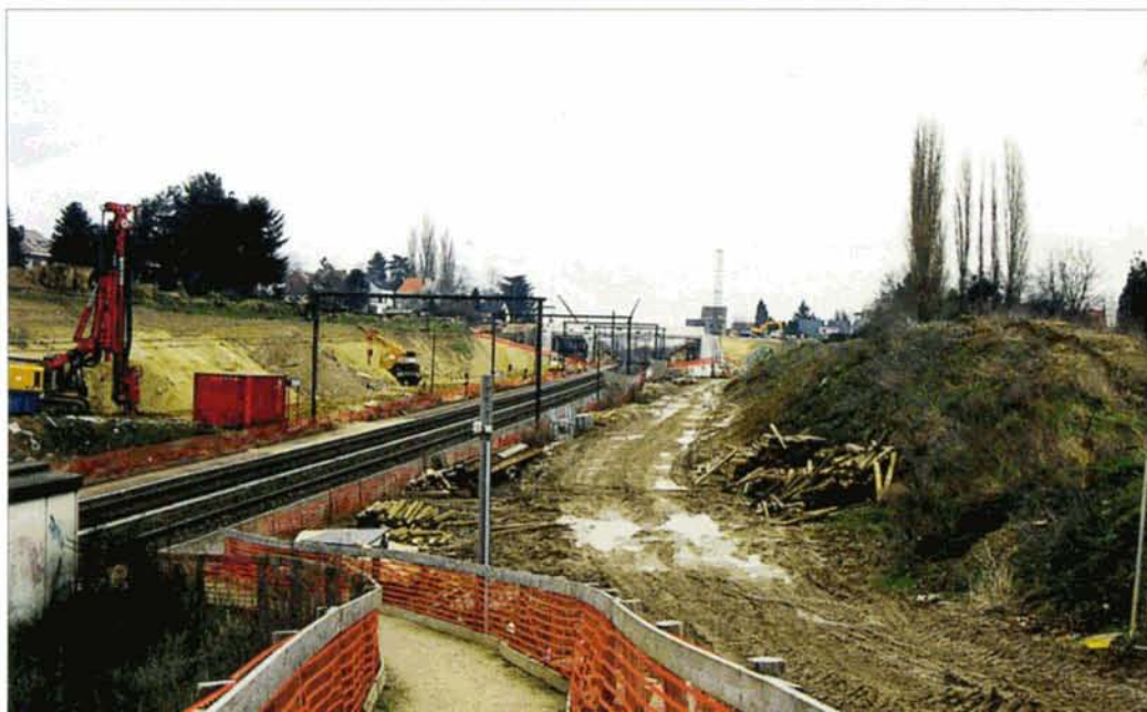
PHOTO 49-88 A Nossegem, les travaux concernent essentiellement l'élargissement de l'assiette. Dans le fond, le nouveau passage supérieur de la route de Mechelen est en service. L'accès aux quais s'effectue de manière plutôt provisoire. Nossegem, 30 janvier 2002. Baudouin DIEU.
