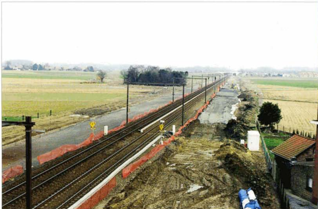
PHOTO 49-88 A Nossegem, les travaux concernent essentiellement l'élargissement de l'assiette. Dans le fond, le nouveau passage supérieur de la route de Mechelen est en service. L'accès aux quais s'effectue de manière plutôt provisoire. Nossegem, 30 janvier 2002. Baudouin DIEU.
