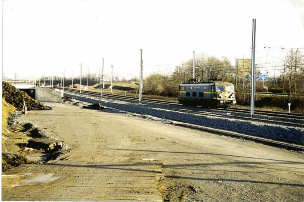
PHOTO 49-93 La 2363 se rend à vide à Antwerpen-Noord. Circulant sur la nouvelle voie A de la ligne 27a, elle passe à hauteur du futur ouvrage qui permettra aux deux voies de la L4 de passer sous celles de la ligne 27a et la voie B de la ligne 12, déjà posée. Noorderdokken, 6 février 2002. Baudouin DIEU.
