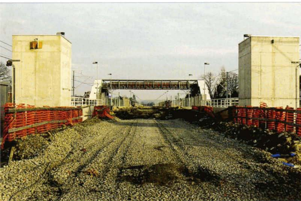
PHOTO 49-91 Le point d'arrêt de Herent. Les nouveaux quais sont en service, tandis que la passerelle n'est plus utilisée. De part et d'autre, les cages des futurs ascenseurs destinés aux personnes à mobilité réduite. Herent, 30 janvier 2002. Baudouin DIEU.
