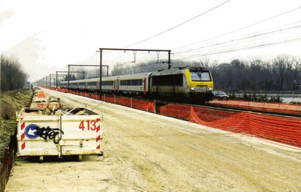
PHOTO 49-90 Entre Erps-Kwerps et Veltem, la nappe phréatique est très haute comme en témoignent les étangs visibles à droite. Les futures voies seront posées sur dalle de béton. Au centre, le train IC-A 536 Eupen-Oostende circule sur l'ancienne voie B de la ligne 36. Baudouin DIEU.
