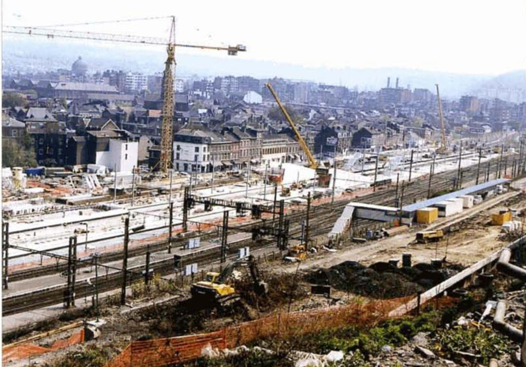
**PHOTO 50-69** Vue générale de la nouvelle gare de Liège-Guillemins prise depuis la colline de Cointe. On distingue la construction des cinq premières voies, qui seront en alignement. Une passerelle provisoire permettra le passage du quai 2 au quai 3. A droite en bas, construction du mur de soutènement de la colline. Liège, 10 avril 2002. B. DIEU.
