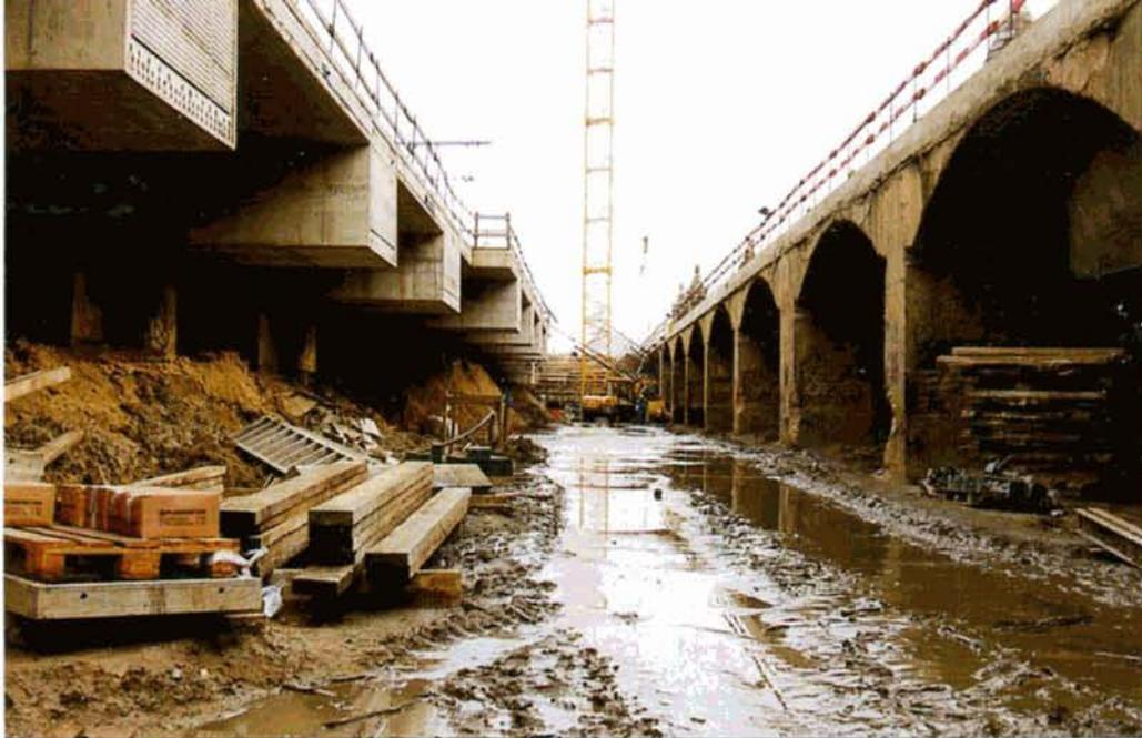
**PHOTO 50-72** Voici ce que le visiteur aperçoit des profondeurs du chantier. A droite, les voûtes cintrées de l'ancien mur de soutènement. A gauche, la demi-voûte du nouveau tunnel qui supporte déjà deux voies qui relient Berchem à Antwerpen. Entre les deux viendra prendre place la seconde demi-voûte en-dessous de laquelle sera creusé le tunnel d'accès aux niveaux -1 et -2. Antwerpen, 20 mars 2002. Baudouin DIEU.
