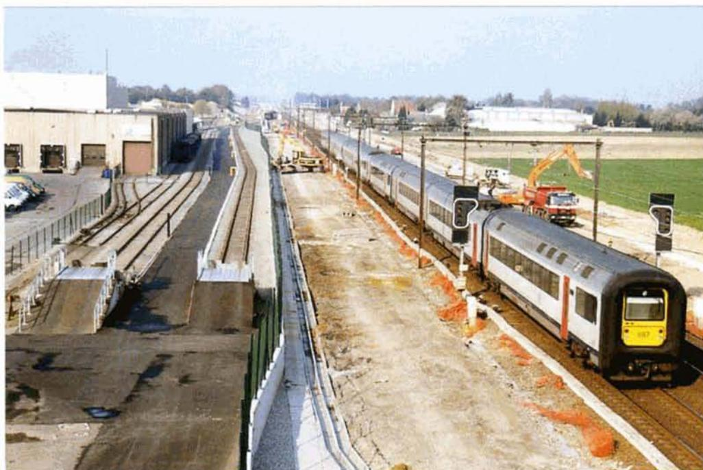
**PHOTO 50-67** Les travaux à Kortenbergh, le 29 mars 2002. Sur la voie B de la ligne 36 circule le train E2235 Genk-Côte, composé de trois AM type 96. De part et d'autre de la ligne 36, construction de l'assiette des nouvelles voies. A gauche, le raccordement D'Ieteren et ses quatre voies. Baudouin DIEU.
