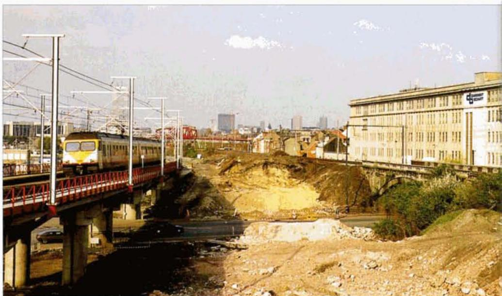
**PHOTO 50-60** *Le pont de l'ancienne assiette de la ligne 50A au-dessus de la rue du Charroi a été démoli en mars. A gauche : le nouveau tracé de la ligne 50A; à droite : la ligne 124. Les travaux de terrassement de l'assiette définitive des lignes 96 et 96N ont débuté à l'entrée de Bruxelles-Midi. Pierre HERBIET, 6 avril 2002.*
