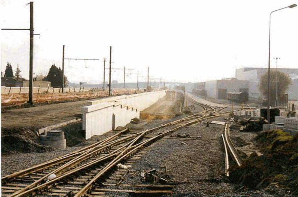
**PHOTO 50-66** Kortenbergh, vue prise vers le raccordement D'Ieteren. Deux branches de la traversée-jonction double seront raccordées à la voie B de la ligne 36, la troisième vers le raccordement et la dernière vers deux voies de manoeuvre. Baudouin DIEU, 29 mars 2002.
