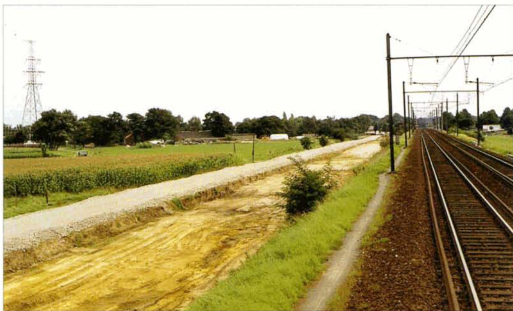
Les travaux du second accès au port d'Antwerpen ont débuté au début de l'été. Au départ d'Antwerpen-Noord, la nouvelle ligne sera parallèle à la ligne 27A jusqu'à un peu après Ekeren, puis bifurquera vers le nord-est pour relier Lier et la ligne 16 (Lier - Aarschot). La mise en service de cette nouvelle ligne est prévue pour 2009. Vue des travaux de terrassement de la nouvelle ligne, parallèle à la ligne 27A, ici à la sortie d'Antwerpen-Noord, le 7 août.
