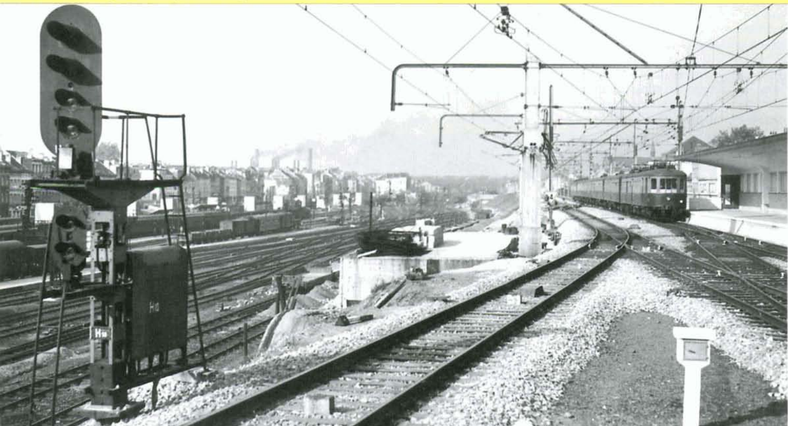
PHOTO BD-149 En gare du Nord, trois voies permettent de traiter le trafic des trains électriques de la ligne d'Anvers, sur les quais 10, 11 et 12. La caténaire de la gare "basse" a déjà disparu dans le cadre des travaux de rehaussement des voies. A gauche, un signal électrique de la signalisation De Rechter. Bruno DEDONCKER, 1950; collection : PFT.
