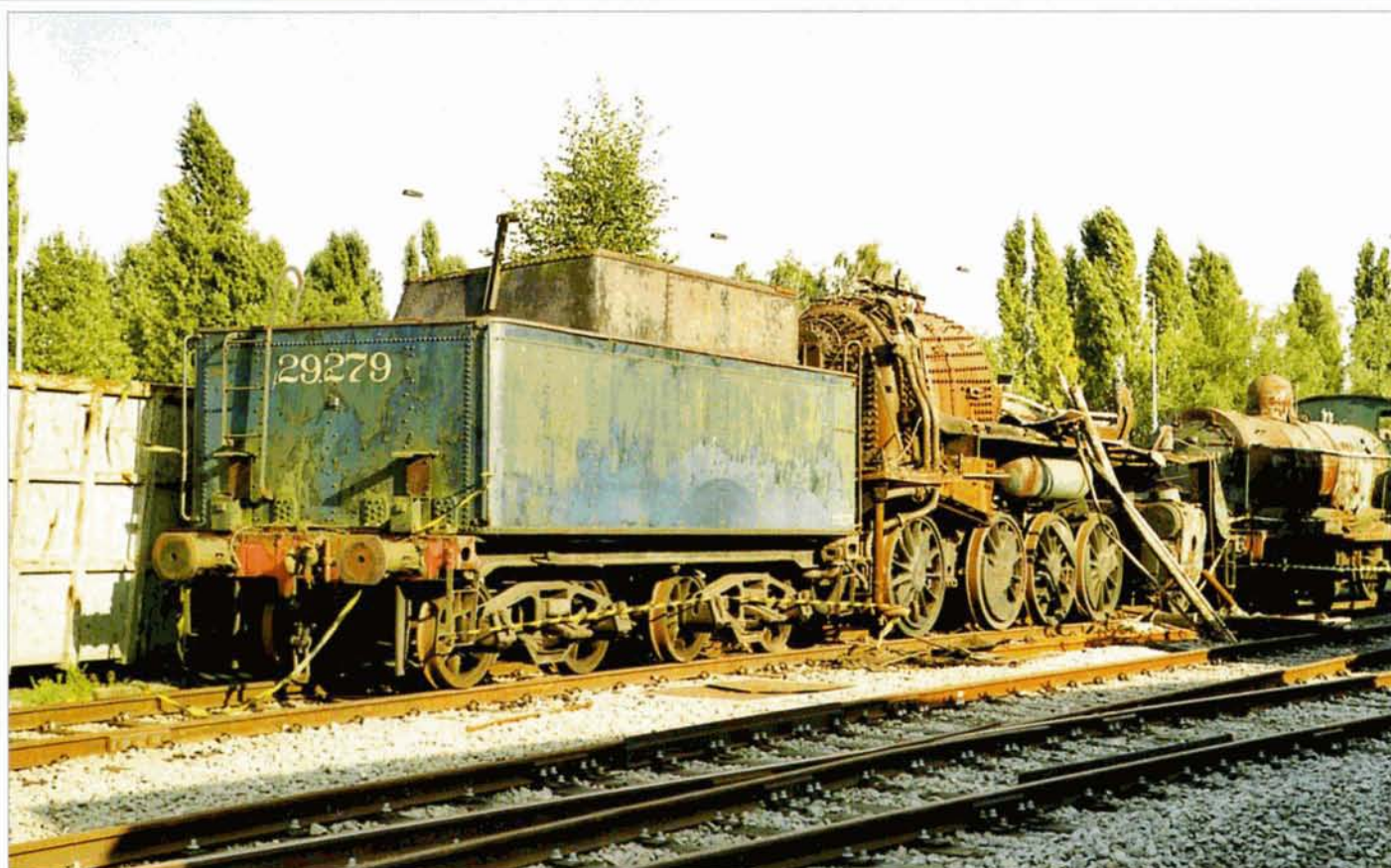
PHOTO 52-33 Les derniers moments de la 29.279. Derrière, on distingue la A621.11. La 29.279 fut construite par Alco en 1946 (numéro 74764). Elle fut mise en service à Stockem le 28-09-1946. Elle fut successivement mutée à Herbesthal (07-1954), Ronet (10-1959), Jemelle (09-1963) et Kortrijk (09-1965), où elle fut radiée le 09-10-1965. A ce moment, elle fut transformée en chaudière mobile A621.202 et servit à cette tâche jusqu'en 1977 à Schaerbeek. Elle fut transférée à Leuven en octobre 1980. Quant à la A621.11, il s'agit de la 44.021 (ex. 4421) construite par La Biesme en 1902 (numéro 1347) et réformée le 03-08-1948. Leuven, 15 septembre 2002. Pierre HERBIET.
