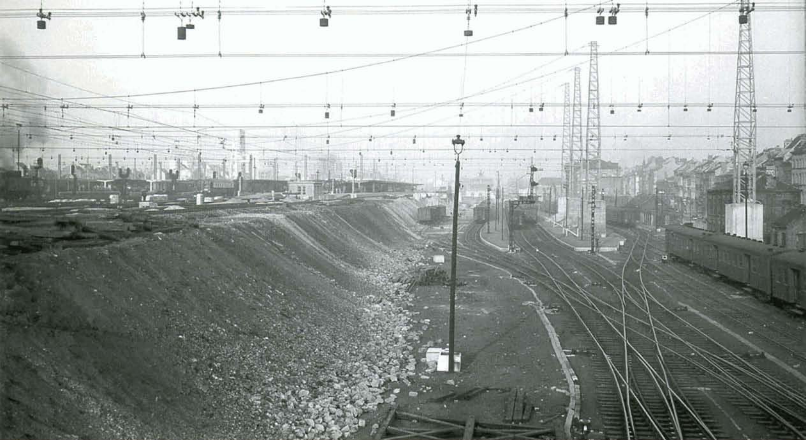
PHOTO BD-148 Vue prise en 1950 depuis Forest vers la gare du Midi. A gauche, douze voies sont en service, en impasse toutefois côté Jonction. A droite, en bas, les voies provisoires servent au départ des trains de la ligne de Charleroi. Les pylônes supports de caténaires ainsi que les portiques souples transversaux sont montés. Bruno DEDONCKER; collection PFT.
