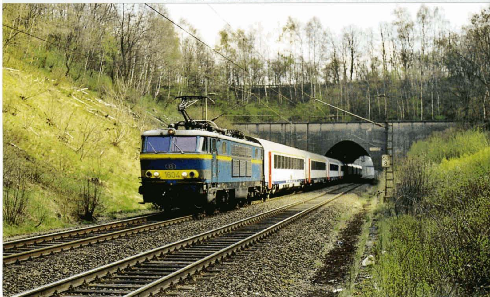
PHOTO 53-34 Le 20 avril 2001, le D420 Köln - Oostende franchit la section à ciel ouvert du tunnel de Königsdorf. Situé entre Eilendorf et Stolberg, ce tunnel, construit de 1837 à 1841 et long de 1623 mètres, est le plus ancien de la DB. De 1955 à 1956, sa partie centrale, en très mauvais état, fut démolie et remplacée par une tranchée. Yves STEENEBRUGGEN.
