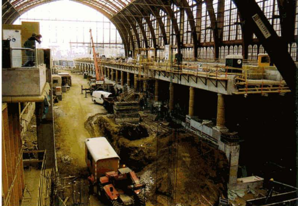
En gare d'Antwerpen-Centraal, la construction des étages inférieurs et supérieurs se poursuit inlassablement. Au centre, un puits de lumière baignera la gare jusqu'au niveau -2. Antwerpen-Centraal, 5 novembre 2002. Baudouin DIEU.
