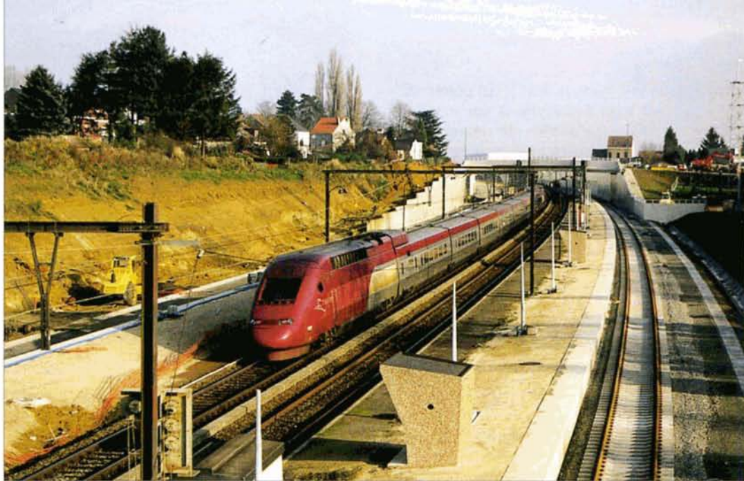
Le site de la gare de Nossegem a bien changé... Les nouveaux quais qui desserviront les voies de la ligne 36 (extérieures) sont construits; la voie vers Bruxelles est posée mais pas électrifiée, et la plate-forme de la voie vers Leuven est prête. Au centre, les voies actuelles de la ligne 36 sur laquelle passe le TGV 9425 Paris-Köln. Nossegem, 22 novembre 2002. Baudouin DIEU.
