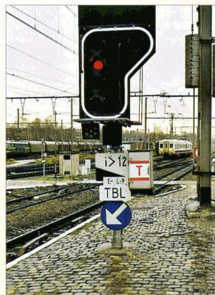
A gauche, le panneau TBL placé sur le mât des signaux pouvant donner accès à une ligne équipée de la TBL. A droite, le panneau TBL implanté à l'entrée des lignes exclusivement équipées de la TBL. Leuven, 28 novembre 2002. Jean-Luc VANDERHAEGEN.
