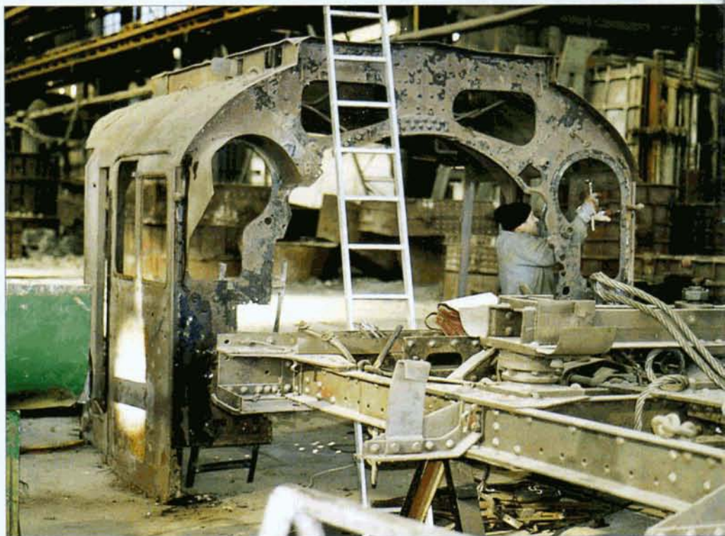
Les travaux de restauration de l'abri de la cabine de conduite.
