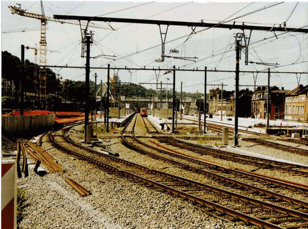
Les cinq premières voies de la nouvelle gare des Guillemins sont posées. On remarquera leur alignement parfait, contrairement aux quais en courbe de l'ancienne gare. À la voie 3 stationne le TGV 9444 Köln-Paris par Bruxelles. Liège, 25 juin 2003. Baudouin DIEU.
