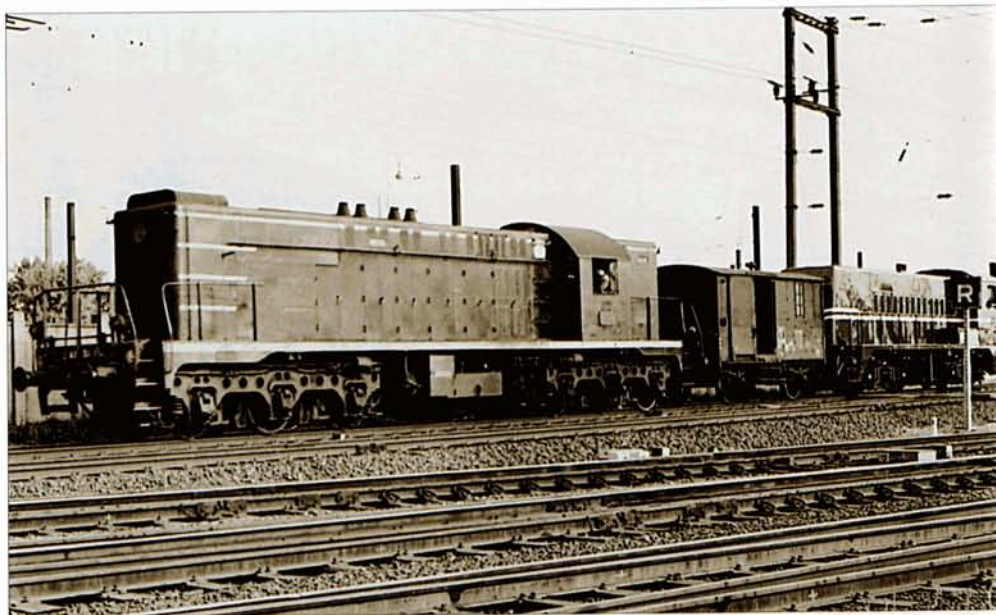
PHOTO BD-158 Le 22 avril 1957, à Thionville, la 040 DA 55 (future A1A A1A 62.055) de la SNCF manoeuvre la 2318 des NS sortant de construction. Cette machine fut déjà mise hors service en juin 1973. Bruno DEDONCKER, collection PFT.
