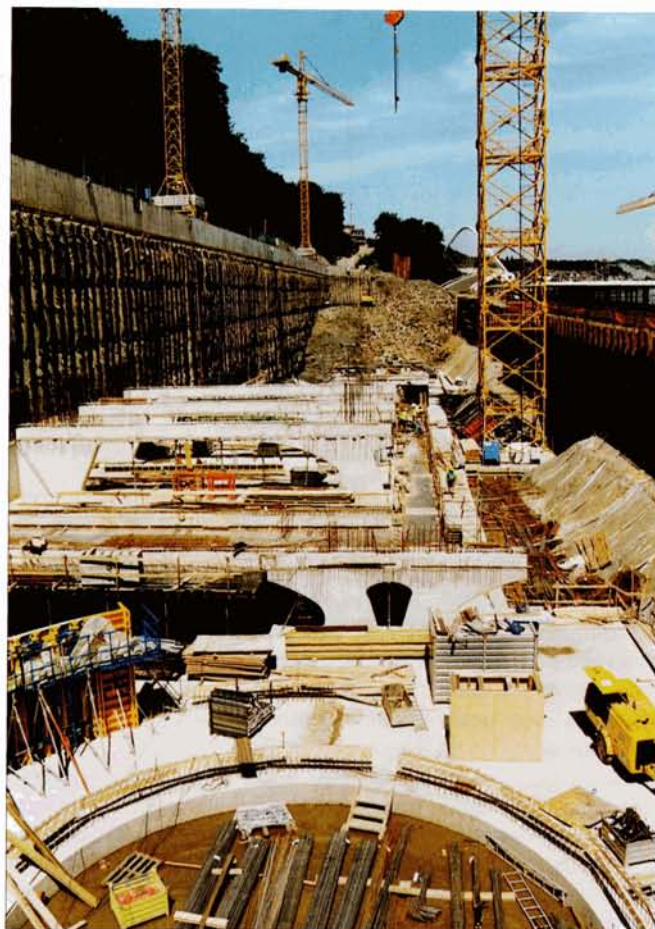
↑ Les travaux de construction du parking côté Cointe. A gauche, le mur de pieux retenant la colline ; à l'avant-plan, la fondation de l'accès en colimaçon aux parties souterraines ; dans le fond, le viaduc routier qui permettra un accès direct depuis l'autoroute. Liège, 25 juin 2003. Baudouin DIEU.
