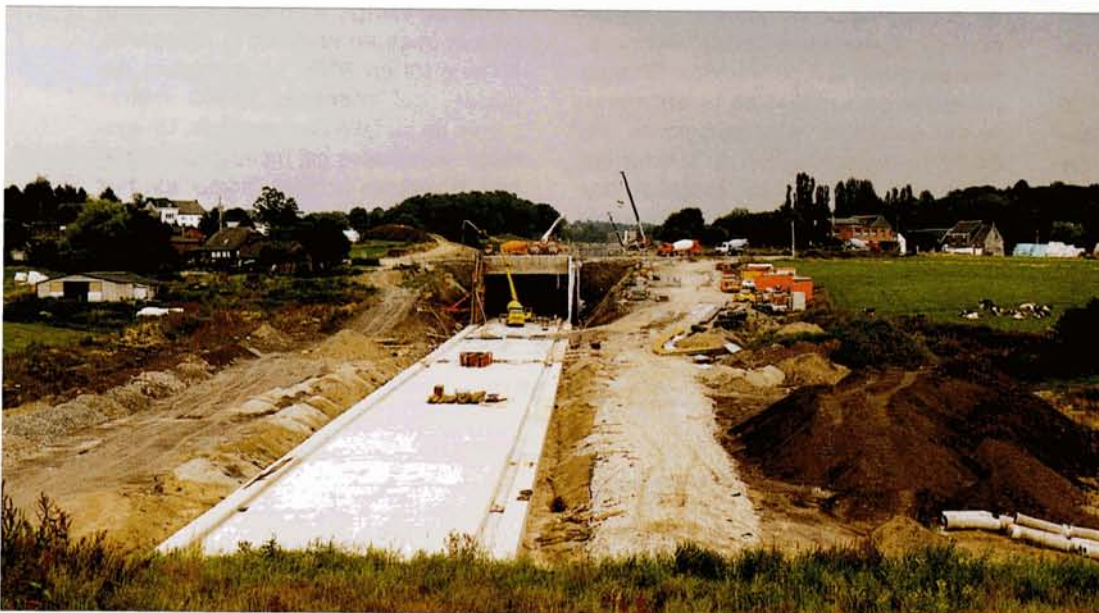
↑ Les travaux de construction du parking côté Cointe. A gauche, le mur de pieux retenant la colline ; à l'avant-plan, la fondation de l'accès en colimaçon aux parties souterraines ; dans le fond, le viaduc routier qui permettra un accès direct depuis l'autoroute. Liège, 25 juin 2003. Baudouin DIEU.
