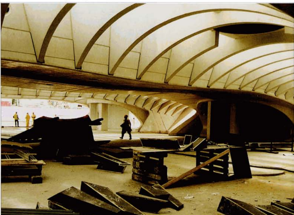
La future salle des pas perdus de la nouvelle gare des Guillemins. L'espace est très lumineux, et les voûtes sont faites de béton coulé sur place à l'aide des moules visibles sur le sol. Liège, 25 juin 2003. Baudouin DIEU.
