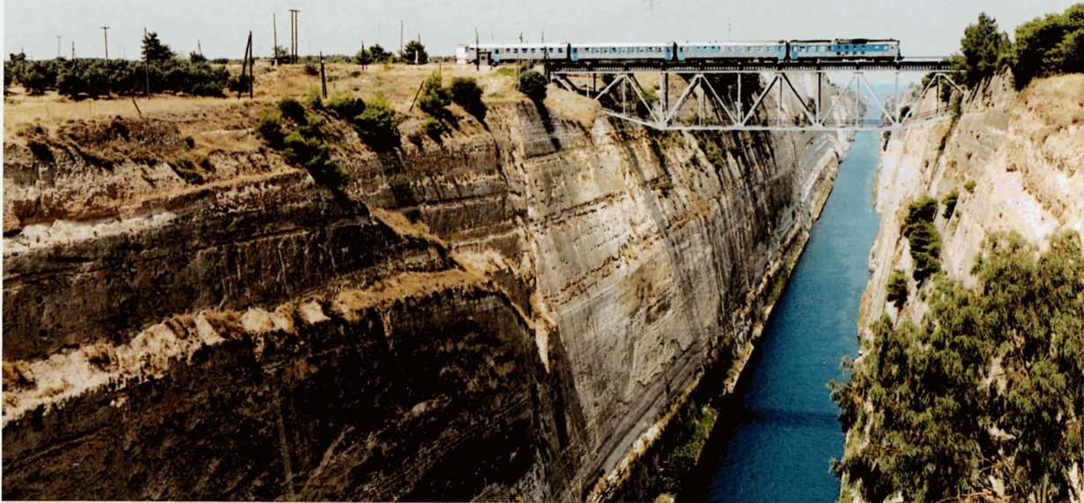
PHOTO 58-54 Le 9 août 1996, deux Ganz-Mavag de la série 6461-6471 assurant le train 301 Kyparissia - Pirée, franchissent le célèbre canal de Corinthe. Ce canal fut creusé de 1882 à 1893, est long de 6.343 m, large de 24,60 m, profond de 8 m, et ses parois atteignent une hauteur maximale de 79,50 m. Il permet de relier le golfe de Corinthe au golfe de Saronique. Jean-Luc VANDERHAEGEN.
