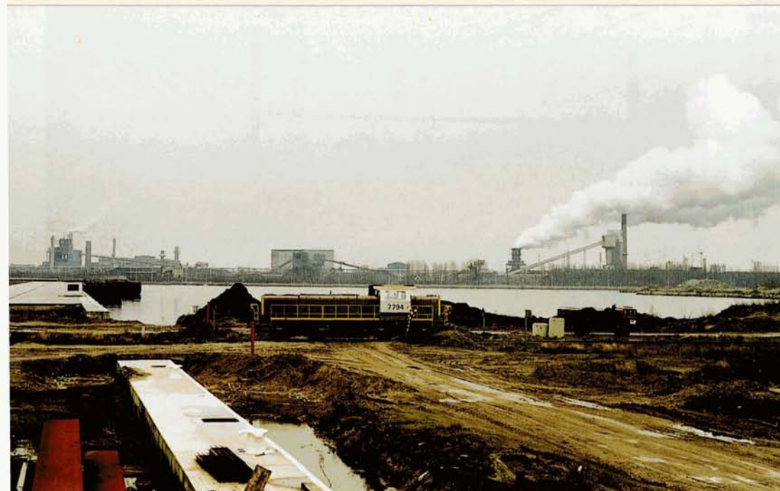
PHOTO 61-29 Voici le fameux Kluizendok en cours de construction. Les murs des quais sont déjà établis, sauf à hauteur du passage de la ligne 55. Sur l'autre rive du canal Gent - Terneuzen, on voit les installations sidérurgique de SIDMAR. Pierre HERBIET, 12 février 2004.
