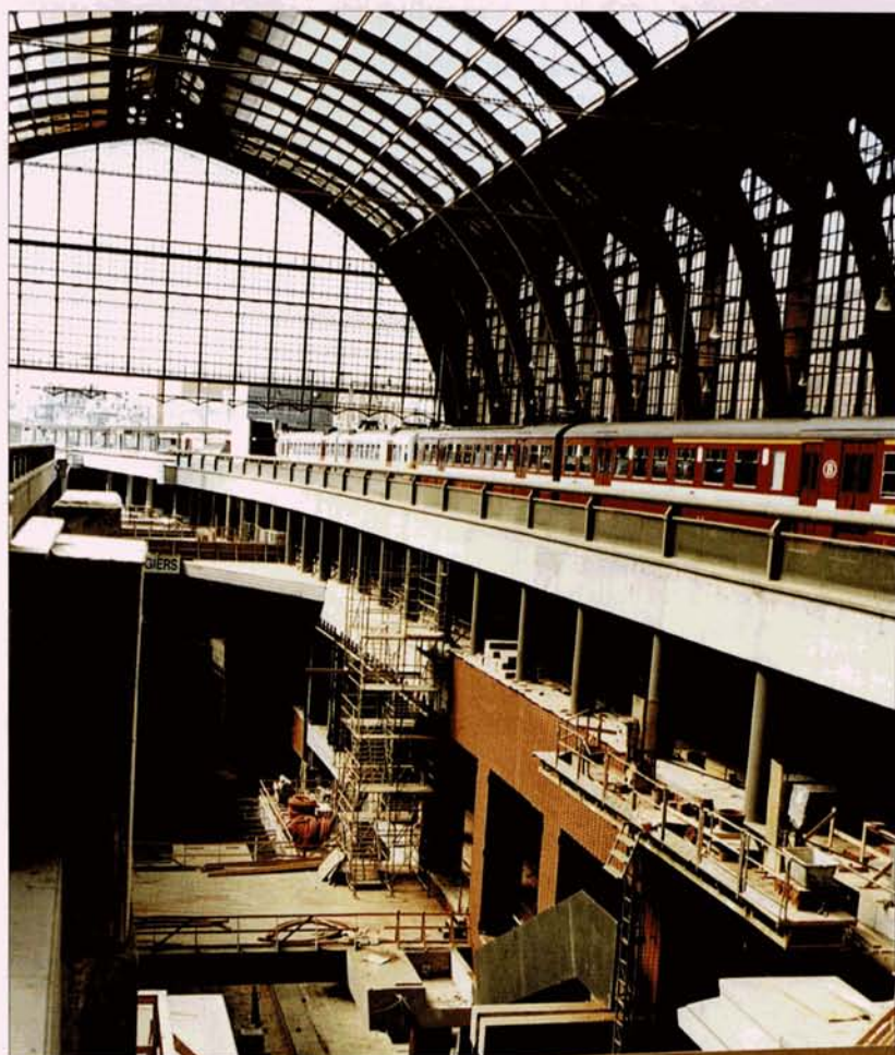
La gare Centrale d'Antwerpen. Dans le fond, le niveau -2 qui verra passer les trains directs transitant par la Jonction Nord-Sud. Le génie civil est terminé et les travaux de finition ont pris le relais. Antwerpen-Centraal, 27 juillet 2005. Baudouin DIEU.
