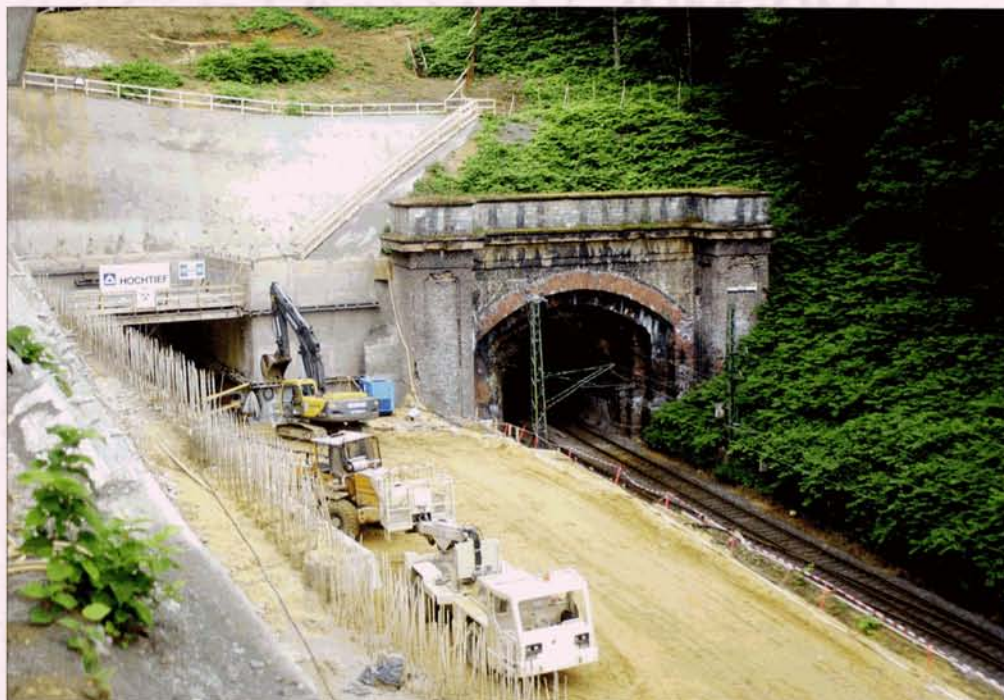
Le percement du nouveau tunnel d'Aachen a débuté au début de cette année. Voici une vue réalisée côté Aachen montrant à gauche l'entrée du nouveau tunnel, et à droite l'ancien "Buschtunnel" (voir à ce sujet EN LIGNES 68 page 43). Pierre HERBIET, 6 juillet 2005.
