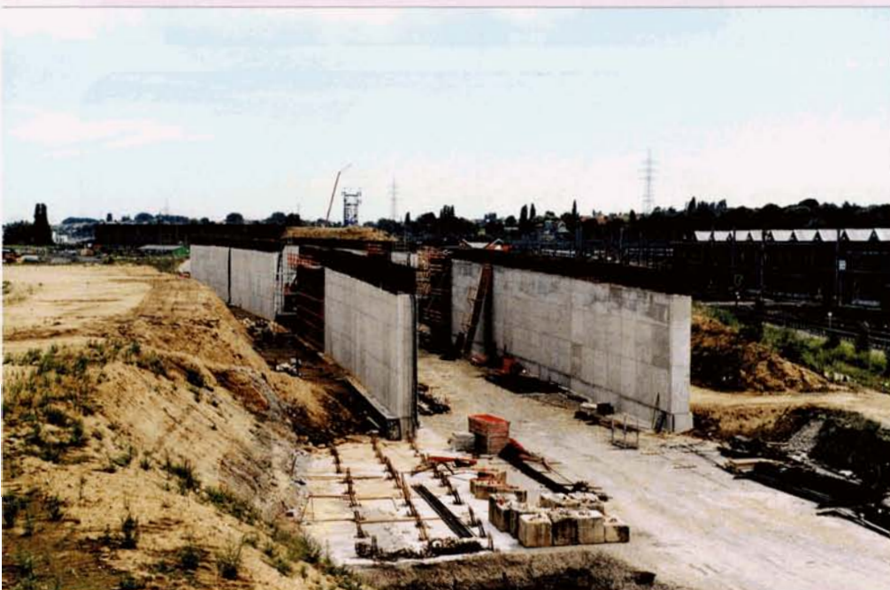
La pose du viaduc d'accès au terminal TGV de Bruxelles-Midi a commencé; les ponts-bacs seront mis en place à l'aide d'un portique mobile se déplaçant sur les piles. Bruxelles-Midi, 12 juillet 2005. Baudouin DIEU.
