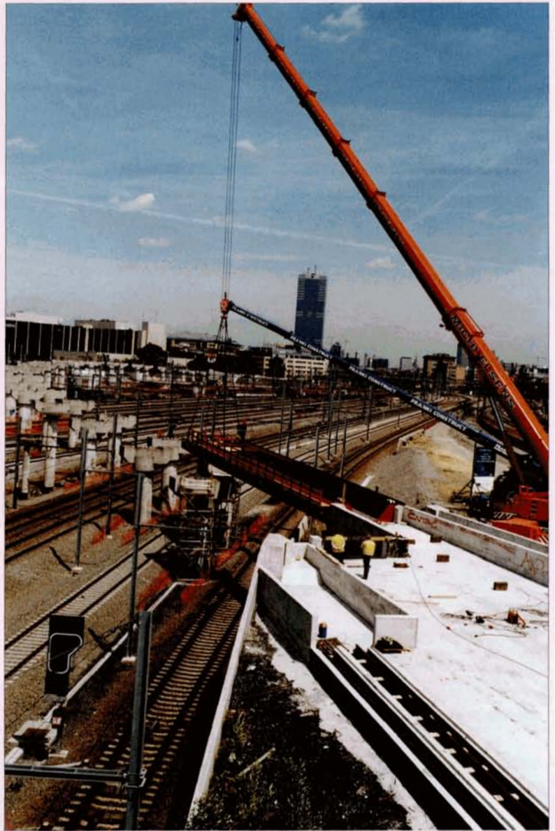
La pose du viaduc d'accès au terminal TGV de Bruxelles-Midi a commencé; les ponts-bacs seront mis en place à l'aide d'un portique mobile se déplaçant sur les piles. Bruxelles-Midi, 12 juillet 2005. Baudouin DIEU.
