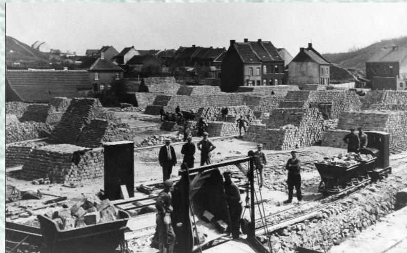
Le chantier de stockage des pavés de la carrière des Sarts était desservi par plusieurs voies à écartement réduit (0,600 m) sur lesquelles circulaient des petits wagonnets basculants manoeuvrés à l'aide d'un petit tracteur à essence (visible à droite de la photo). Collection Michel DUHAUT.
