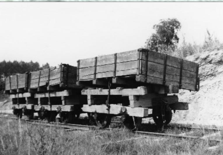
*Voici une série de trois wagonnets à voie métrique originaires de la carrière Vandevelde utilisés après la reprise par les CUP au transport de terres. Le châssis et les bennes sont en bois.
