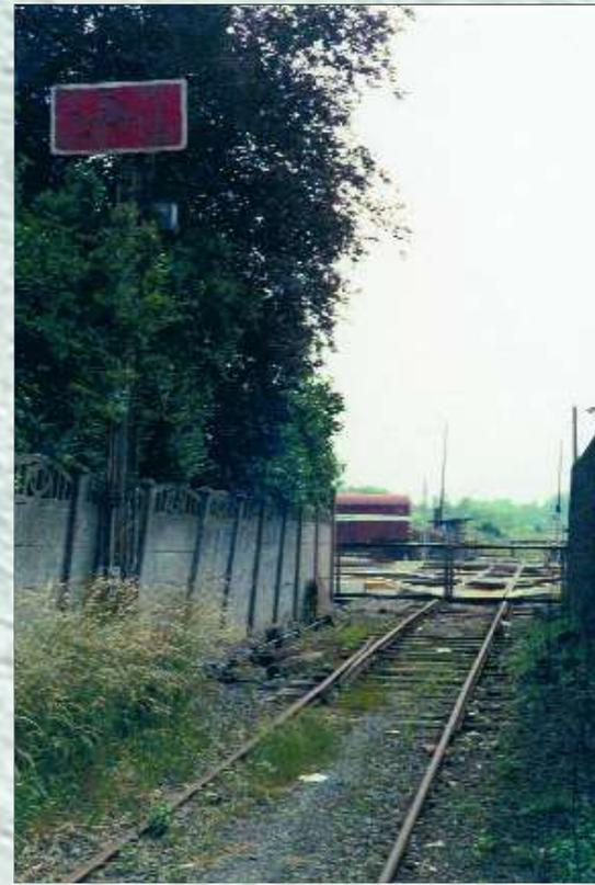
*Le signal d'arrêt qui protégeait la traversée de la gare aux trains CUP venant de la Dendre et se dirigeant vers la carrière. Le signal et l'aiguille de déraillement étaient commandés simultanément par le même levier du block 14 de la gare de Lessines.*
