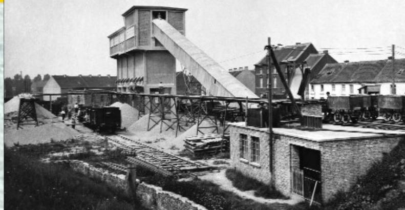
**Le concasseur de la carrière des Sarts. A droite, on voit les wagonnets chargés de produits à concasser et, à gauche, le chemin de fer aérien servant à la mise en stock de produits finis le long d'une voie sur laquelle des wagons de l'Etat sont en cours de chargement à l'aide de brouettes. On remarque les planches disposées entre les aires de stockage et celles sur lesquelles roulent les brouettes.**
