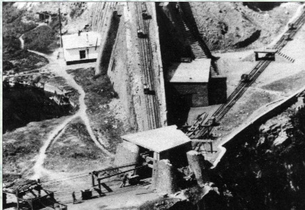
*A la carrière Tacquenier, les wagonnets étaient traînés par chaîne vers la surface via des plans inclinés à double voie. Collection Michel DUHAUT.*
