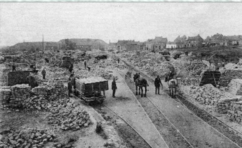
Le magasin à pavés de la carrière Vandeveld vers 1910. Les pavés étaient transportés dans des wagons métalliques à tampons central et écartement métrique, lesquels étaient manoeuvrés par des chevaux .
