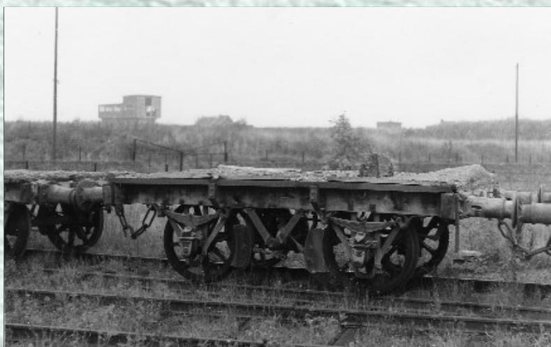
**↑ Le wagon plat n° 183 des CUP, le 11 octobre 1959. Ce wagon possédait un châssis en bois, un frein à levier, des tampons type Etat Belge et des attelages à chaîne sans tendeur.**
