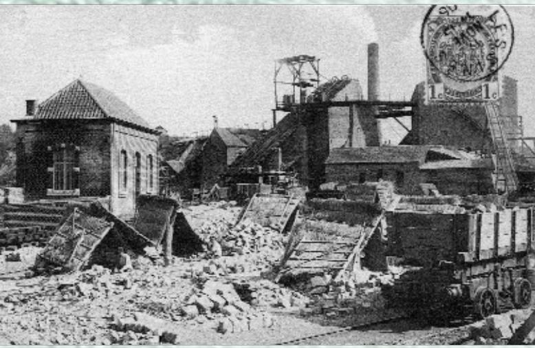
Une berce à caisse en bois de la carrière Lenoir Frères chargée de pavés, au chantier d'épénage. Les deux tampons placés à hauteur inférieure à celle des tampons des wagons de l'Etat, nécessitaient d'équiper les locomotives des deux systèmes. Dans le fond au milieu, le sommet du plan incliné de la carrière aboutissant au concasseur est bien visible. *Collection Michel DUHAUT.*
