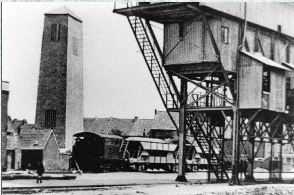
**Après avoir traversé la gare et la rue de la Station, le raccordement Tacquenier arrivait au rivage de la Dendre. Deux wagons Baume et Marpent de 40 t remorqués par une locomotive Cockerill à chaudière verticale du type IV provenant de l'ancienne carrière Saint-Roch, arrivent au rivage. A droite, on voit le chargeur.**
