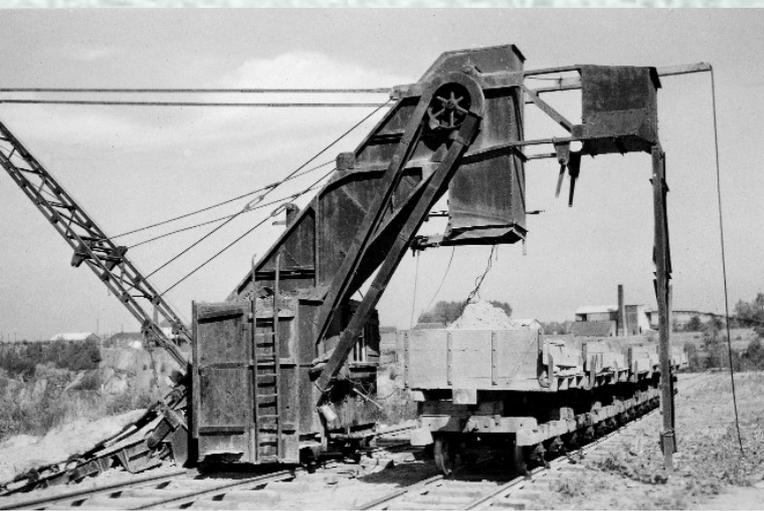
*Après l'absorption de la carrière Vandevelde par les CUP, le matériel à voie métrique fut transféré au siège Emile Lenoir pour transporter les terres vers Deux-Acren. Ici, chargement des terres par un excavateur à godets. Photo B. DEDONCKER, collection PFT.*
