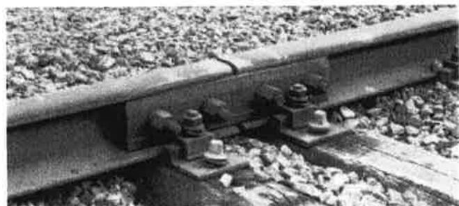
Traverses en bois, éclisses en acier moulé, joint de dilatation libre positionné entre deux traverses.
