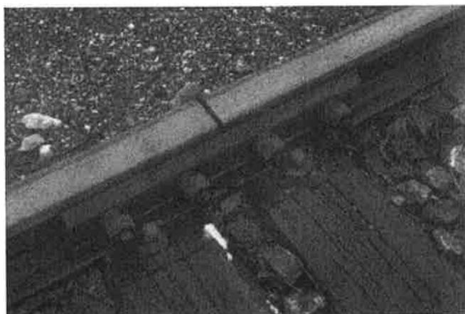
Traverses en bois, éclisses en acier moulé, joint de dilatation libre positionné entre deux traverses. (gare de Sourbrodt)
