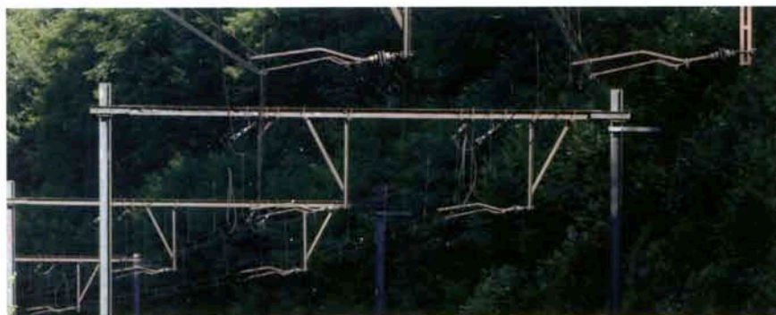
antibalançants et biellettes utilisés dans les courbes à très fort dévers
