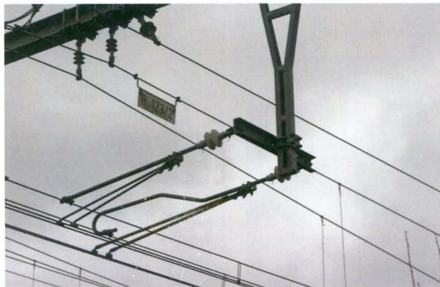
antibalançant normal et antibalançant « crosse », avec leurs biellettes
