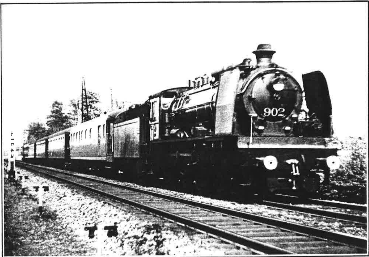
Locomotive n°902 en tête d'un train Bruxelles - Lille. Elle est accouplée à un tender type 38 (ex-KPEV) de 31m 3 . Ruysbroek, 1935. photo J-F. VAN PUYVELDE
