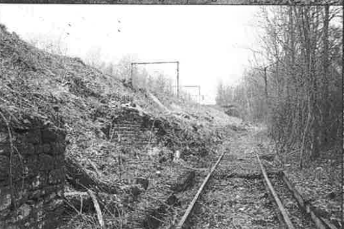
Tiroir le long de la ligne 161
