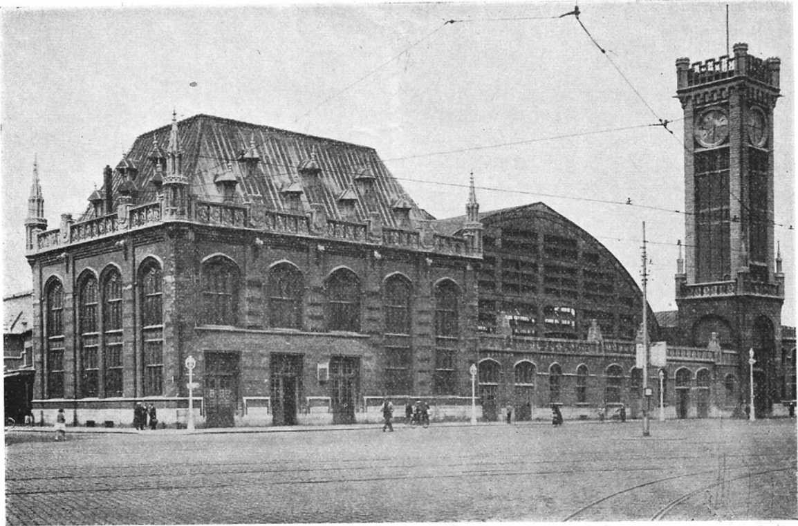
Aanzicht van het station Oostende-Stad
