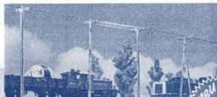
FAL 955 POTEAUX TELEGRAPHIQUES TELEGRAAFPALEN 306,-
