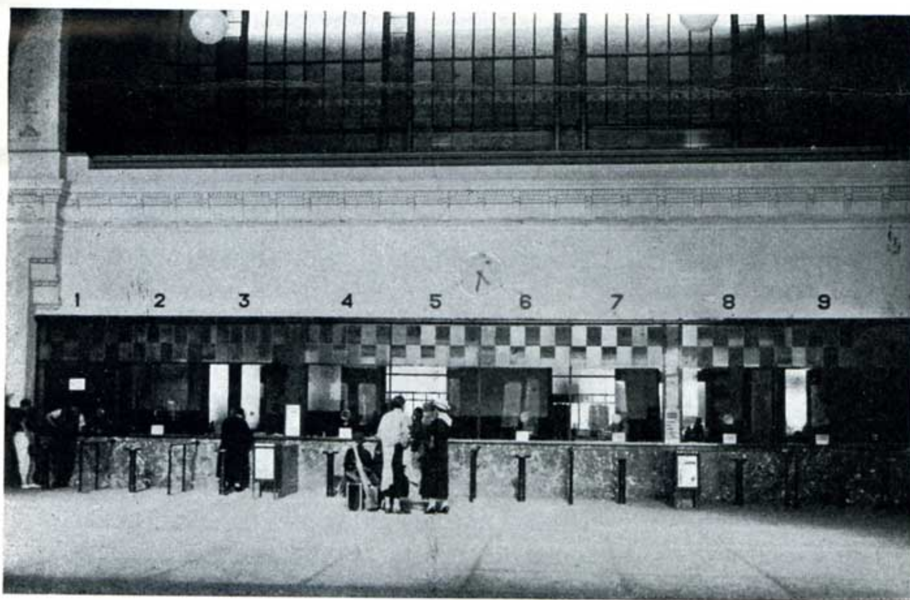
Ostende-Quai — Salle des pas perdus, après modernisation
