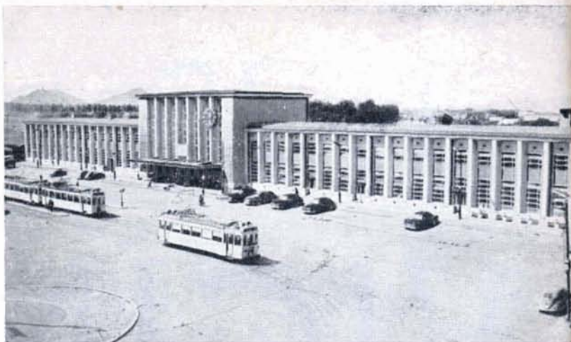
Des fenêtres du bâtiment de la S.N.C.V., on découvre cette vue d'ensemble de la nouvelle gare S.N.C.B.
