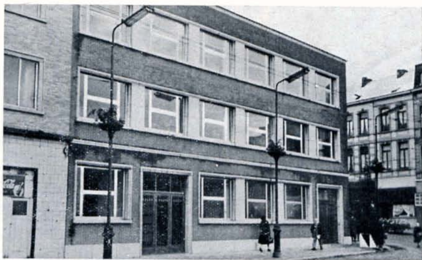
Façade du bâtiment donnant sur la Place Léopold. A droite, la rue de la Houssière par où descendent les trams venant de la Grand'Place.
