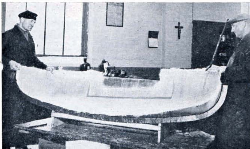
W. Neven et J. Dirix vont démouler le dôme en plastique qui séchera au sol.
