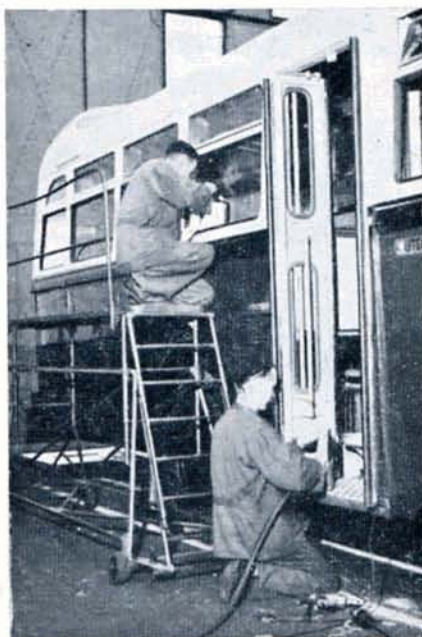
P. Thoelen et J. Smits parachèvent l'extérieur de la carrosserie.
