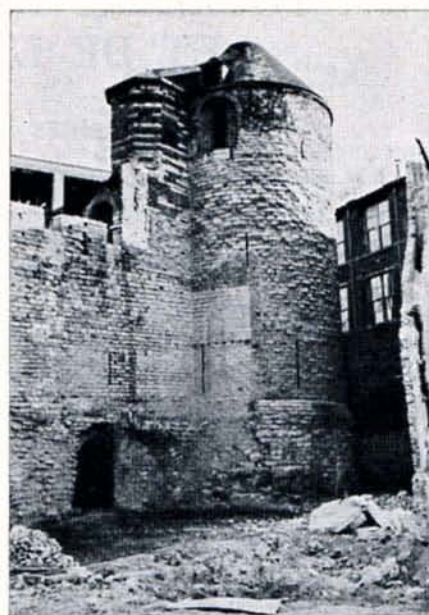
Vestige de la 1 re enceinte.
