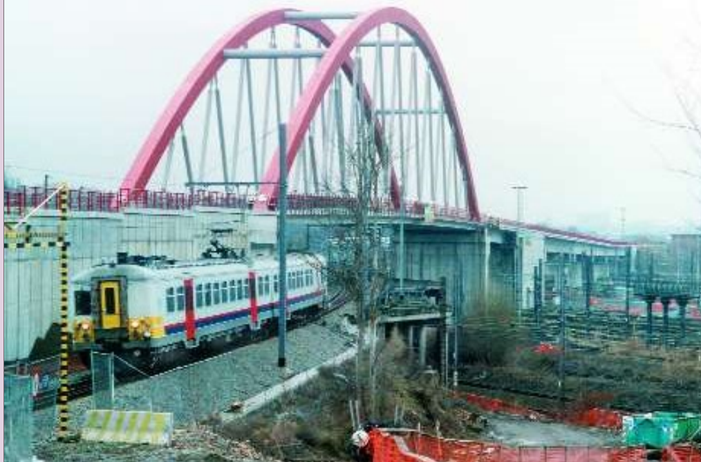
De hoofdoverspanning van het viaduct van Schaarbeek bestaat uit een bowstring, te vergelijken met die in Halle, Leuven en Antwerpen-Luchtbal. Ze werd op het viaduct afgewerkt en nadien op haar definitieve plaats geduwd. Deze operatie vond plaats tijdens het weekend van 29 en 30 oktober 2005.
