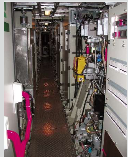
De machinekamer met centrale gang. Eric VANHOECK.
