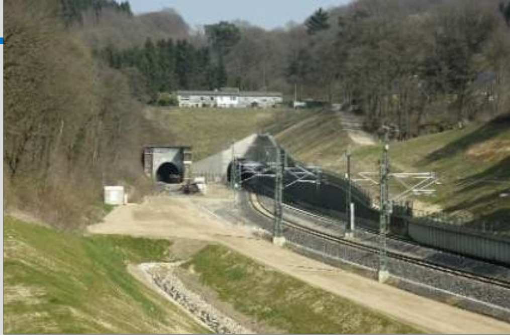
FOTO 91-62 Een zicht op de actuele situatie op Belgisch grondgebied aan de Buschtunnel te Aachen (lijn Aachen - Welkenraedt). Marc DERIEUX, 3 april 2009.
