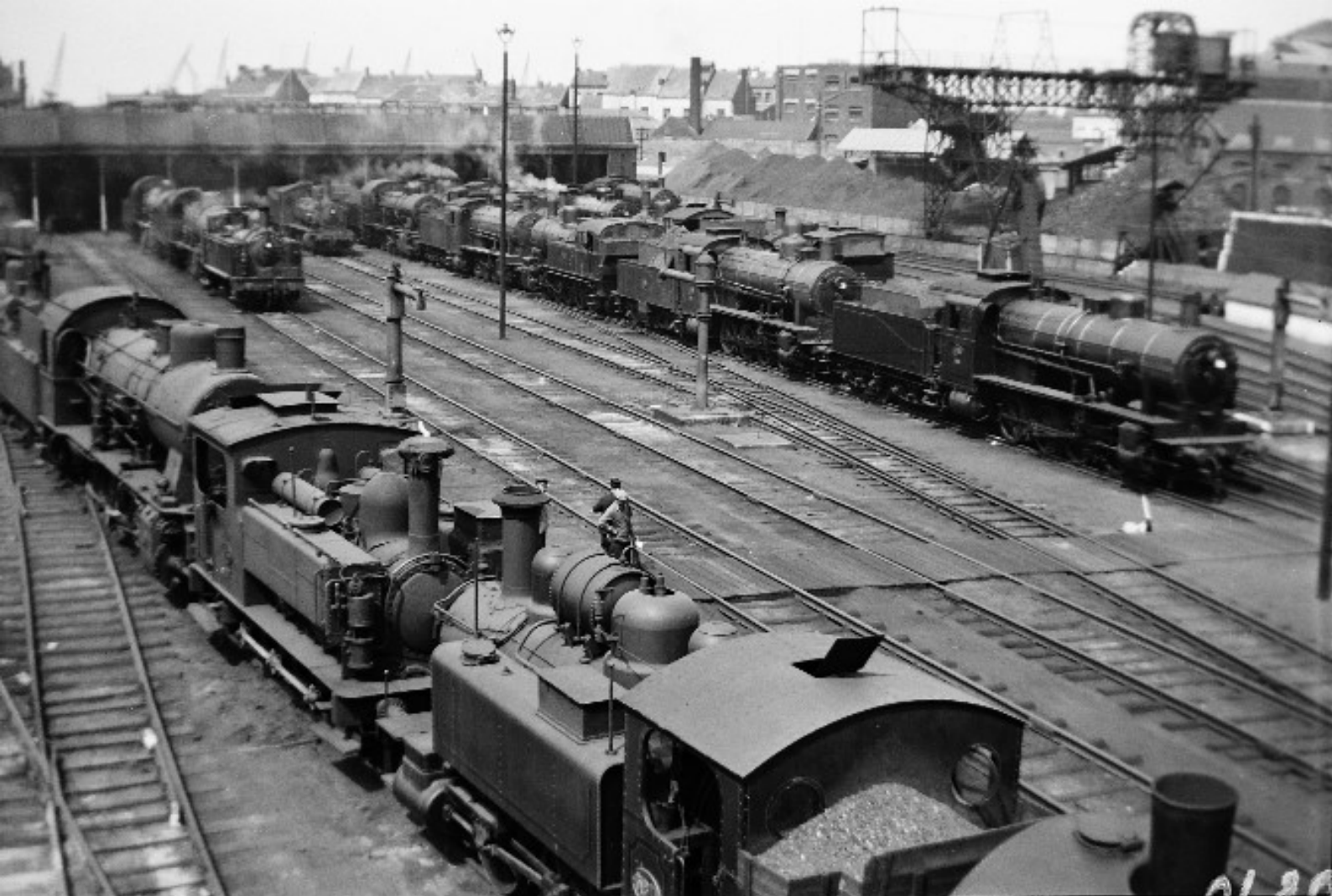
De stelplaats van Antwerpen-Dam, gefotografeerd op zondag 29 april 1934. In de rij rechts bevinden zich vier G8.1 (type 81) en één T16 (type 98). In het midden voor de deuren staan een type 53 en enkele G7.2 (type 72). Vandaag is deze loods verbouwd tot een overdekte ruimte. De muren werden gesloopt, het dak en de ondersteunende pilaren werden gerestaureerd. Zij kreeg de naam "Olifant", verwijzend naar één van de eerste locomotieven die reden op 5 mei 1835. H.G. HESSELINK, verzameling Du Cabri.
