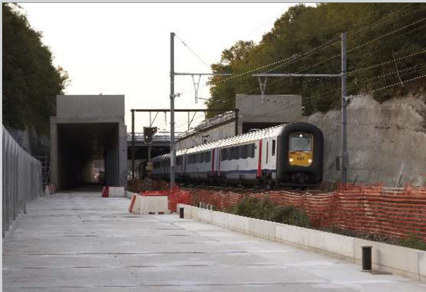
FOTO 94-94 Ter hoogte van de Rue des Renivaux bouwt men een overdekte sleuf over de vier GEN-sporen waardoor de huidige overweg wordt afgeschaft. Op dit zicht richting Ottignies kunnen we ook zien dat de bovenleiding werd aangepast voor de bouw van dit kunstwerk. Het dak van de sleuf bestaat uit prefab-balken die   n voor   n 's nachts geplaatst worden. Ottignies, 19 september 2009. Olivier JOASIN.
